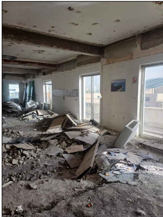
Εικόνα 3.7: Υφιστάμενη κατάσταση εσωτερικά του κτιρίου (4)
