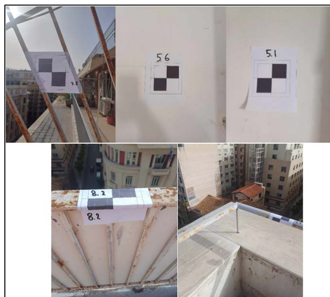
Εικόνα 3.12: Τοποθέτηση και αρίθμηση των στόχων
