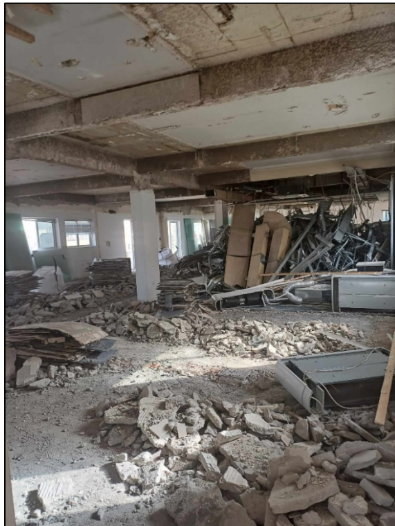
Εικόνα 3.5: Υφιστάμενη κατάσταση εσωτερικά του κτιρίου (2)
