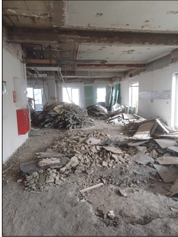
Εικόνα 3.6: Υφιστάμενη κατάσταση εσωτερικά του κτιρίου (3)
