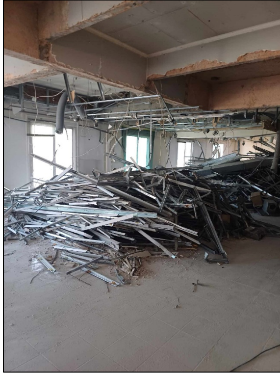
Εικόνα 3.4: Υφιστάμενη κατάσταση εσωτερικά του κτιρίου (1)
