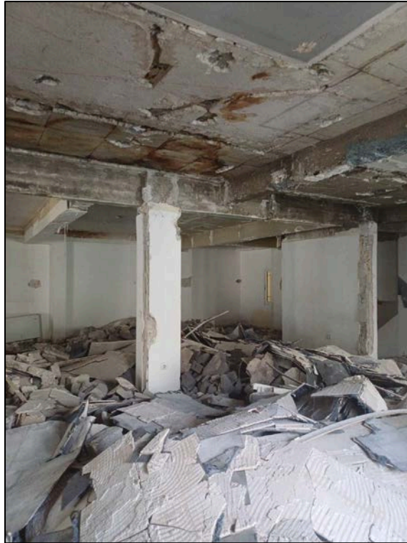
Εικόνα 3.8: Τρέχουσα κατάσταση εσωτερικά του κτιρίου (5)
