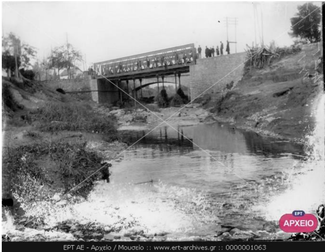
Εικόνα 12: Ο Κηφισός Ποταμός στο σημείο με τις τρεις γέφυρες
