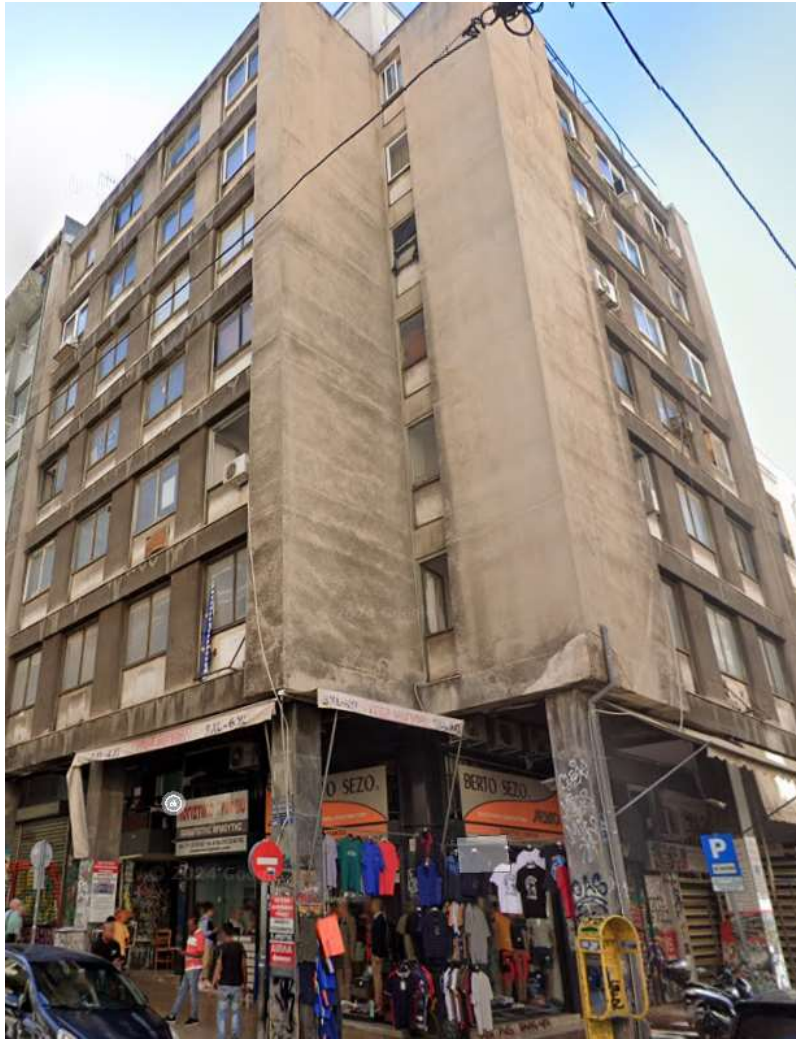
Εικόνα 54 Πολυώροφο κτήριο στην συμβολή των οδών Σωκράτους και Σοφοκλέους
