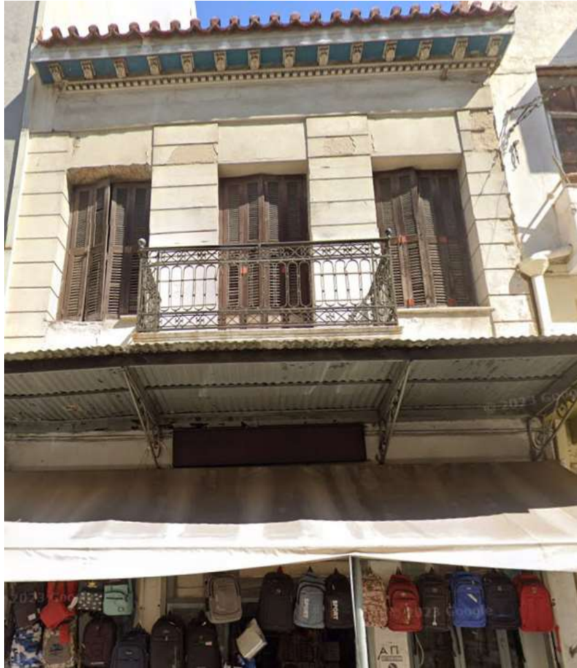
Εικόνα 51 Διώροφο διατηρητέο Κληροδοτήματος Χαρίση Ζήκου-Τσομπάνου
