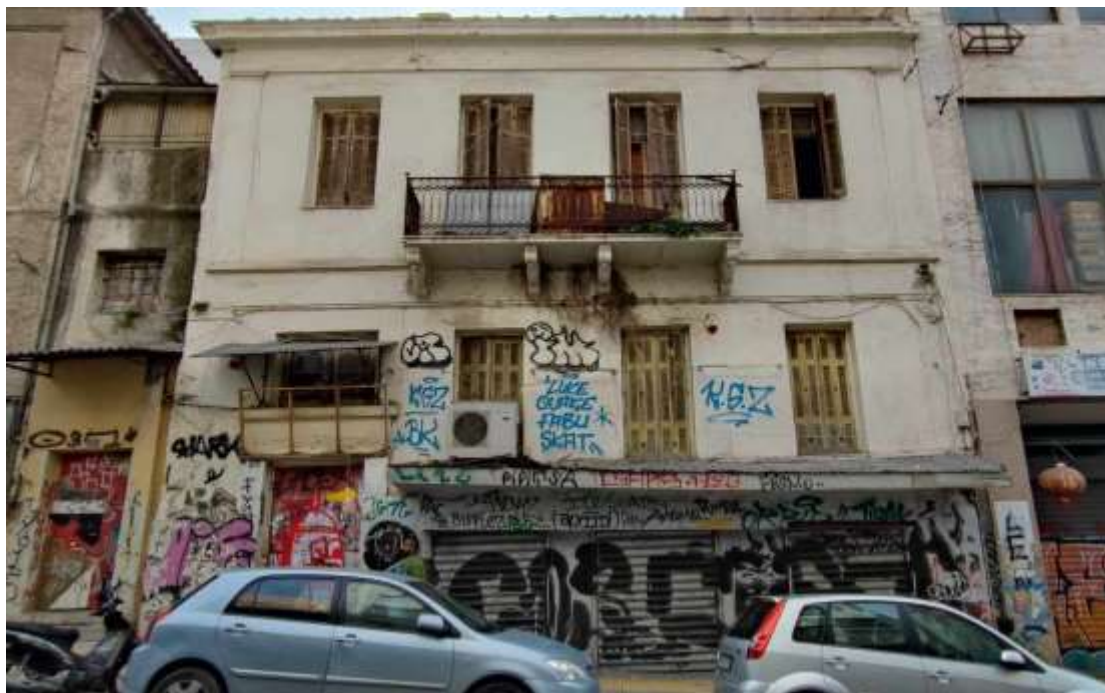
Εικόνα 55 Διατηρητέο τριώροφο σε ιδιοκτησία του ΕΦΚΑ στην Σοφοκλέους 39
