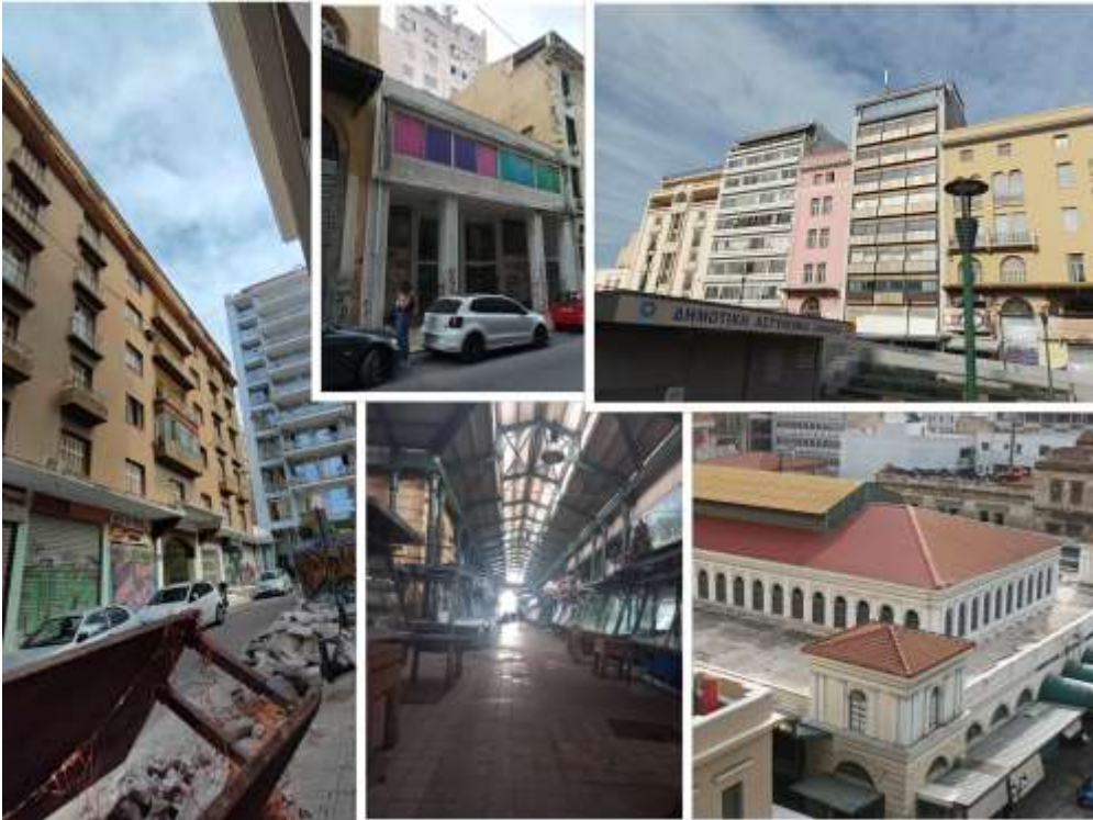
Εικόνα 17 Σύνθεση φωτογραφιών επιτόπιας έρευνας της περιοχή μελέτης
