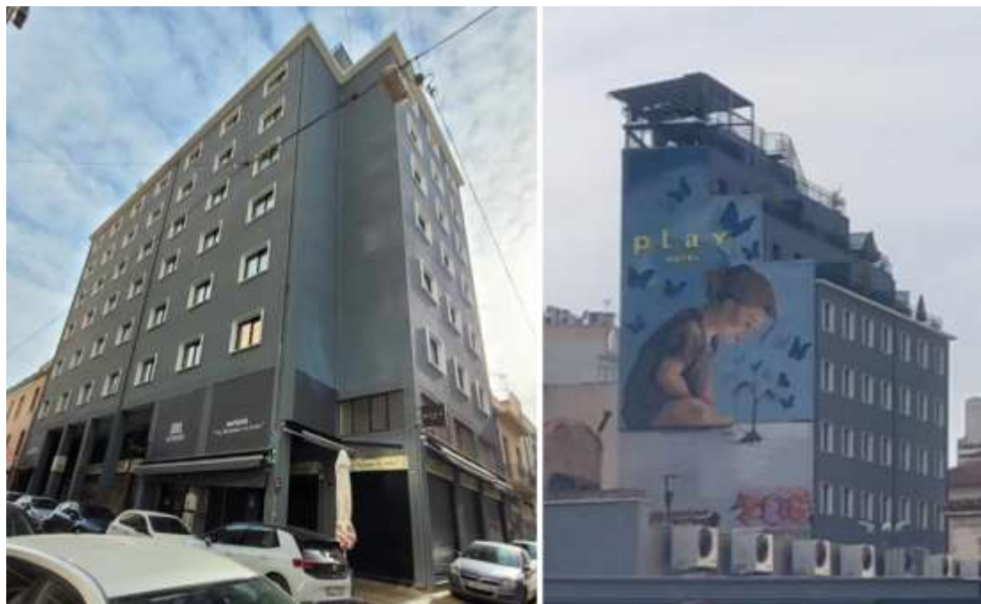
Εικόνα 58 Πολυώροφο κτήριο στις οδούς Διπλάρη και Θεάτρου
