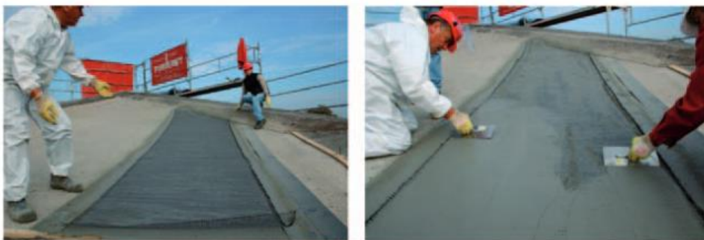
Εικόνα 4: Διαδικασία ενίσχυσης δομής κέλυφους hyper, [11].
