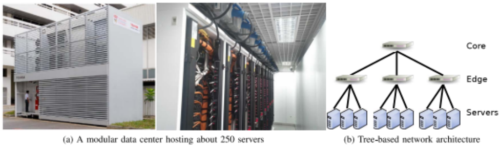
Σχήμα 1.1 : Μια αρθρωτή πλατφόρμα κέντρου δεδομένων που αναπτύχθηκε από το Τεχνολογικό Πανεπιστήμιο Nanyang (NTU) και την Toshiba και η αρχιτεκτονική δικτύου 2 επιπέδων που βασίζεται σε δέντρα.[1]
