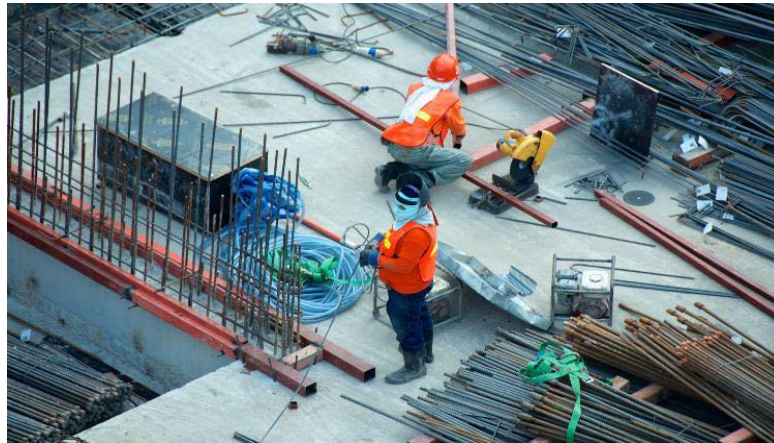
Εικόνα 3.1: Φωτογραφία από πάνω με τρεις οικοδόμους στην οροφή ενός κτιρίου με χάλυβινο οπλισμό που δένεται για ξυλότυπους σκυροδέματος, Kuala Malaysia-june 16, 2017
