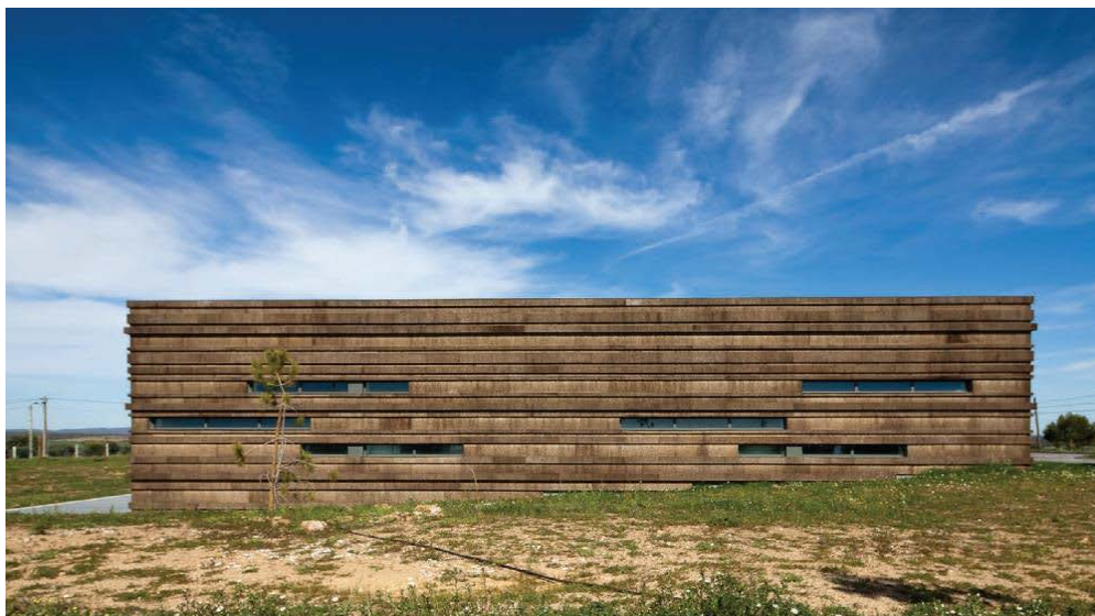
Εικόνα 3.24: Όψη του κτιρίου, φωτογραφία της PMC Arquitectos © João Morgado.
