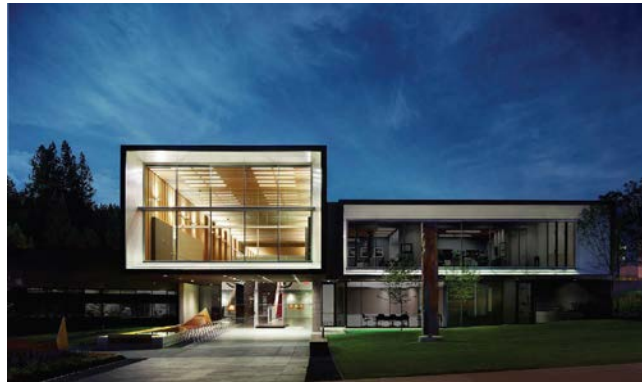
Εικόνα 3.18: Φωτογραφία της MGA | Michael Green Architecture © Martin Tessler «Γενική εικόνα του συστήματος»
