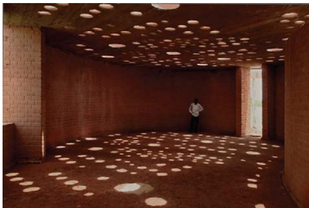
Εικόνα 3.37: «Εσωτερική άποψη που δείχνει τα φωτεινά μοτίβα που παράγονται από την κεραμική οροφή» φωτογραφία © Kéré Architecture
