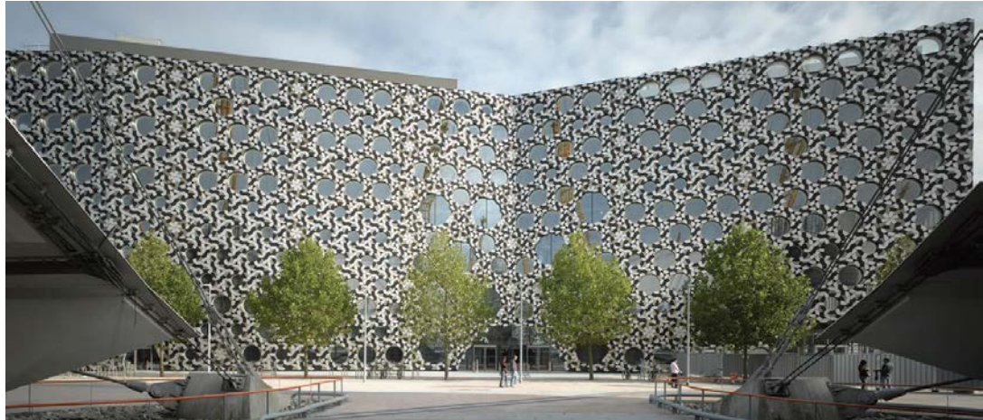
Εικόνα 3.32: Εξωτερική άποψη της πρόσοψης από αλουμίνιο, φωτογραφία του Farshid Moussavi Architecture © Benedict Luxmoore
