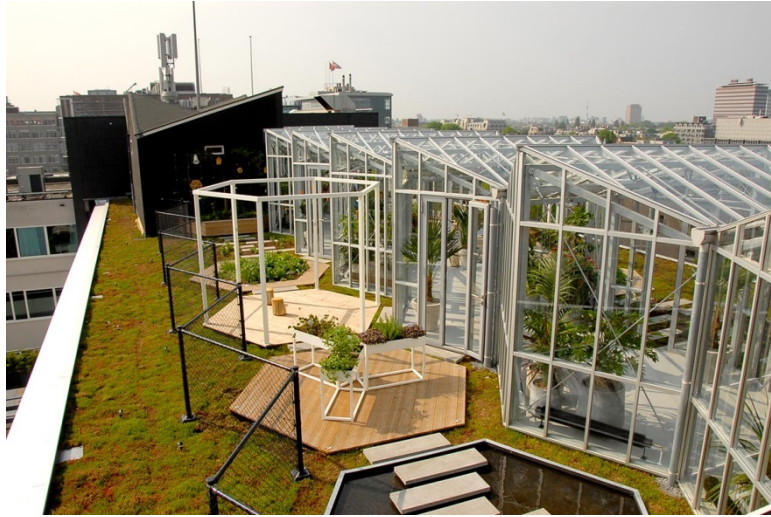
Εικόνα 6.12: Φυτεμένο δώμα στο ξενοδοχείο Roof Garden https://www.greenroofs.com/projects/zoku-metropoolgebouw-metro-pool-building-roof-garden/
