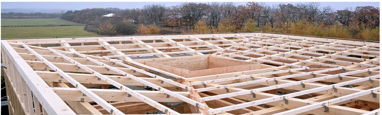
Εικόνα 7.12: Ξύλινη κατασκευή οροφής (χωνί) του κτιρίου
