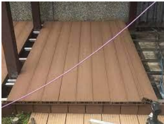
Εικόνα 3.13: Δάπεδο εξωτερικού χώρου από OSB
