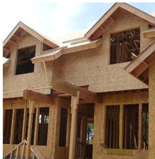
Εικόνα 3.12: Κτήριο κατασκευασμένο με ξύλο OSB
