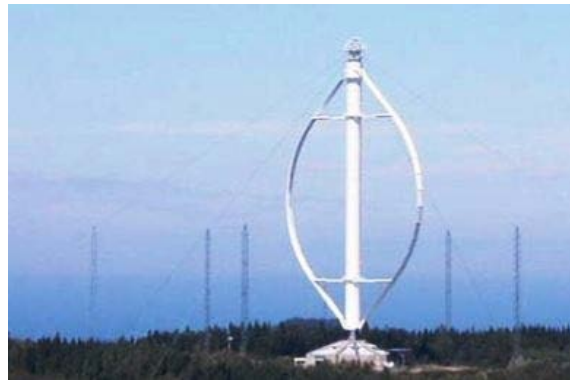
Εικόνα 2.6: Ανεμογεννήτρια κατακόρυφου άξονα
