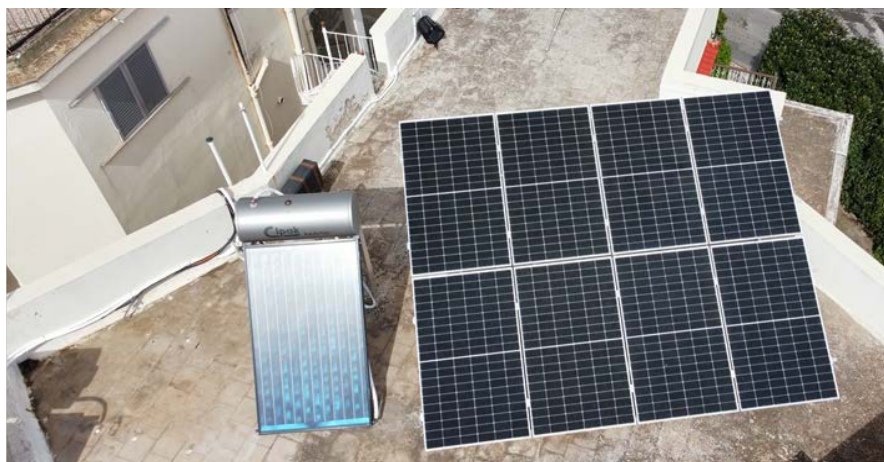
Εικόνα 4.5: Μελέτη ενεργειακής αναβάθμισης με το πρόγραμμα Εξοικονομώ Αυτονομώ, φωτογραφίες πριν και μετά, φωτογραφίες αρχείου ευγενική προσφορά του τεχνικού γραφείου GVenergy – Γιώργος Βογιατζάκης – Ηλεκτρολόγος Μηχανικός.
