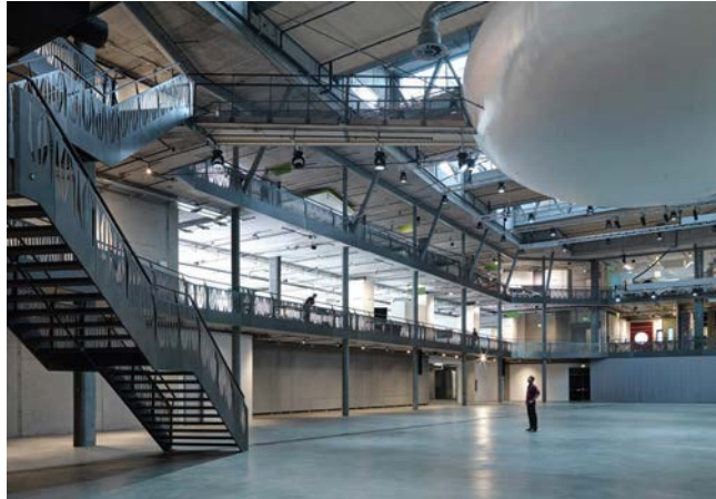
Εικόνα 7.8: Εσωτερική άποψη που δείχνει το θερμοενεργό δάπεδο από σκυρόδεμα, φωτογραφία René Schmid Architekten
