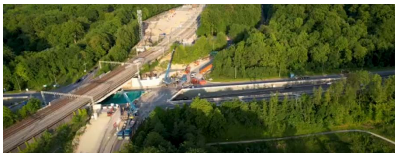
Εικόνα 5.14: Στιγμιότυπο της εξέλιξης του έργου Έργο σε εξέλιξη - Inhijzen brugdelen Ecorecreaduct De Priorij
