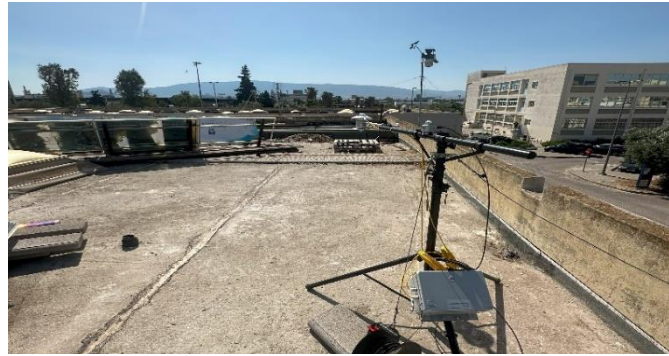
Εικόνα 17 Διάταξη οργάνου στο πεδίο με το Δώμα του Κτηρίου Γ.
