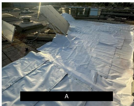
Εικόνα 18 (Α) Τοποθέτηση λευκού PVC. (Β) Το αλμπιντόμετρο πάνω στο λευκό PVC.
