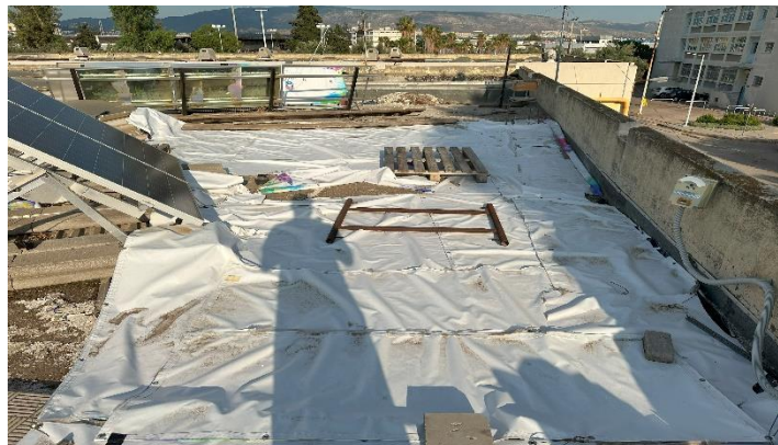
Εικόνα 22 Εγκατάσταση λευκού PVC μετά τη βροχόπτωση.
