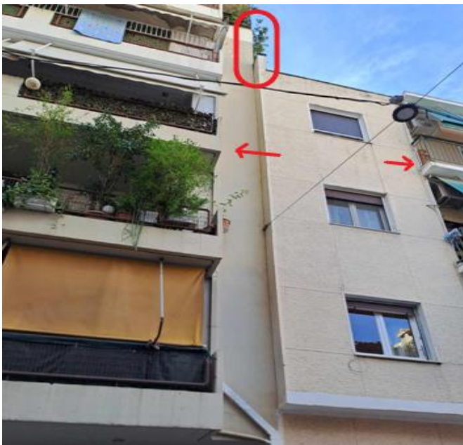
Σχήμα 4.6: Κρούση με γειτονικά κτίρια.
