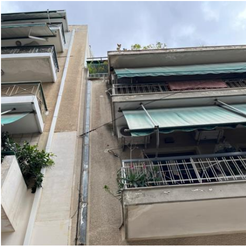
Σχήμα 4.16: Κρούση γειτονικών κτιρίων.
