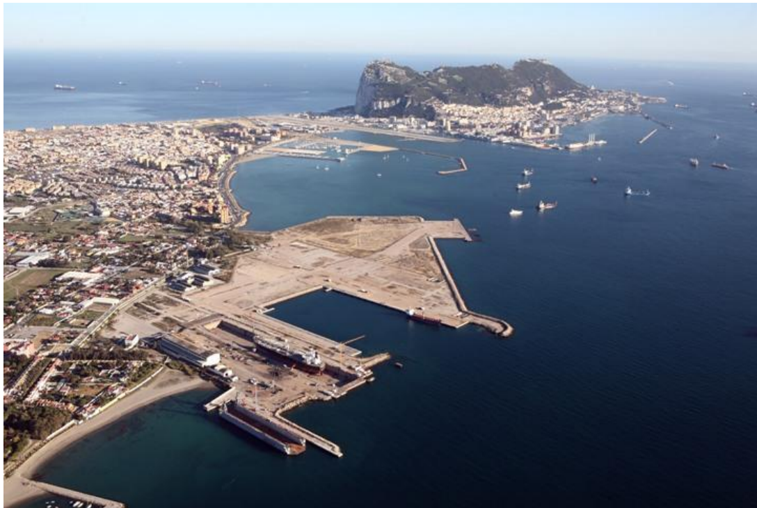
Εικόνα 7: Λιμένας Αλχεθίρας, πηγή : www.harboursreview.com
