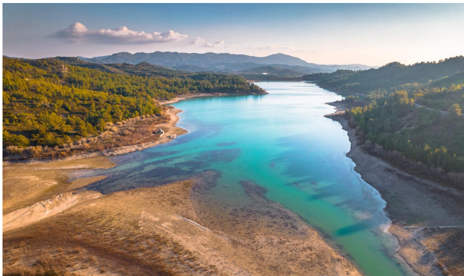
Εικόνα 4.5 Φράγμα Απολακκιάς (Χατζηπέτρος, 2023)
