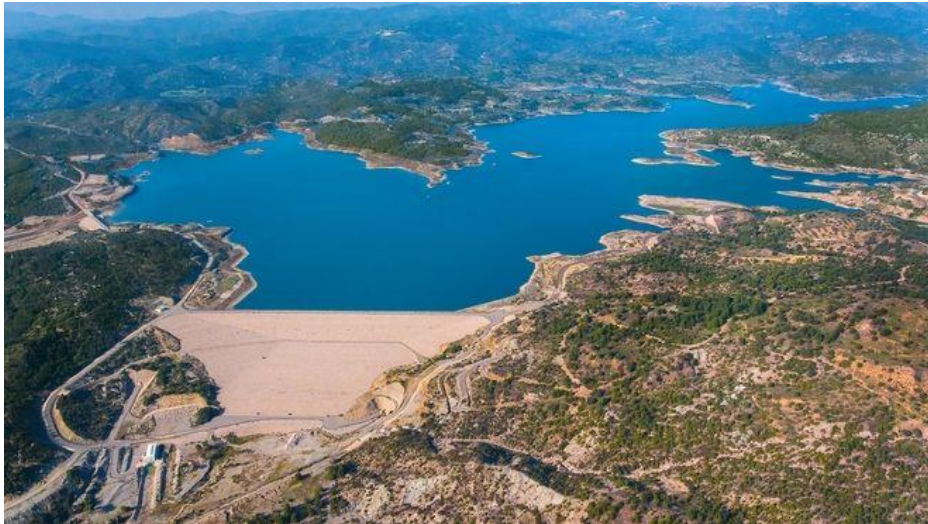
Εικόνα 4.4 Φράγμα Γαδουρά (Ροδιακή, 2024)
