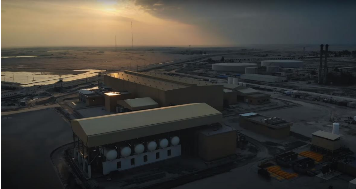
Εικόνα 2.7 Εγκαταστάσεις Solar Desalination Plant Al Khafji (Savener, 2023)
