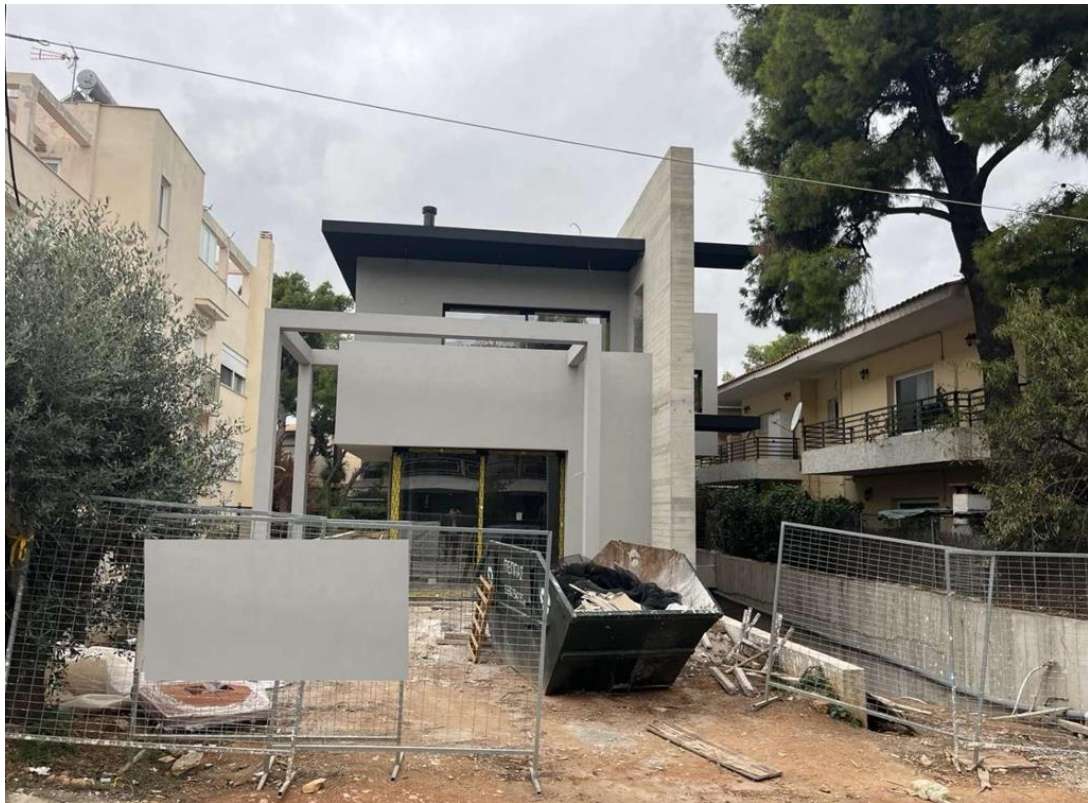
Εικόνα 25. Φωτογραφικό υλικό από την πραγματική κατασκευή #3
