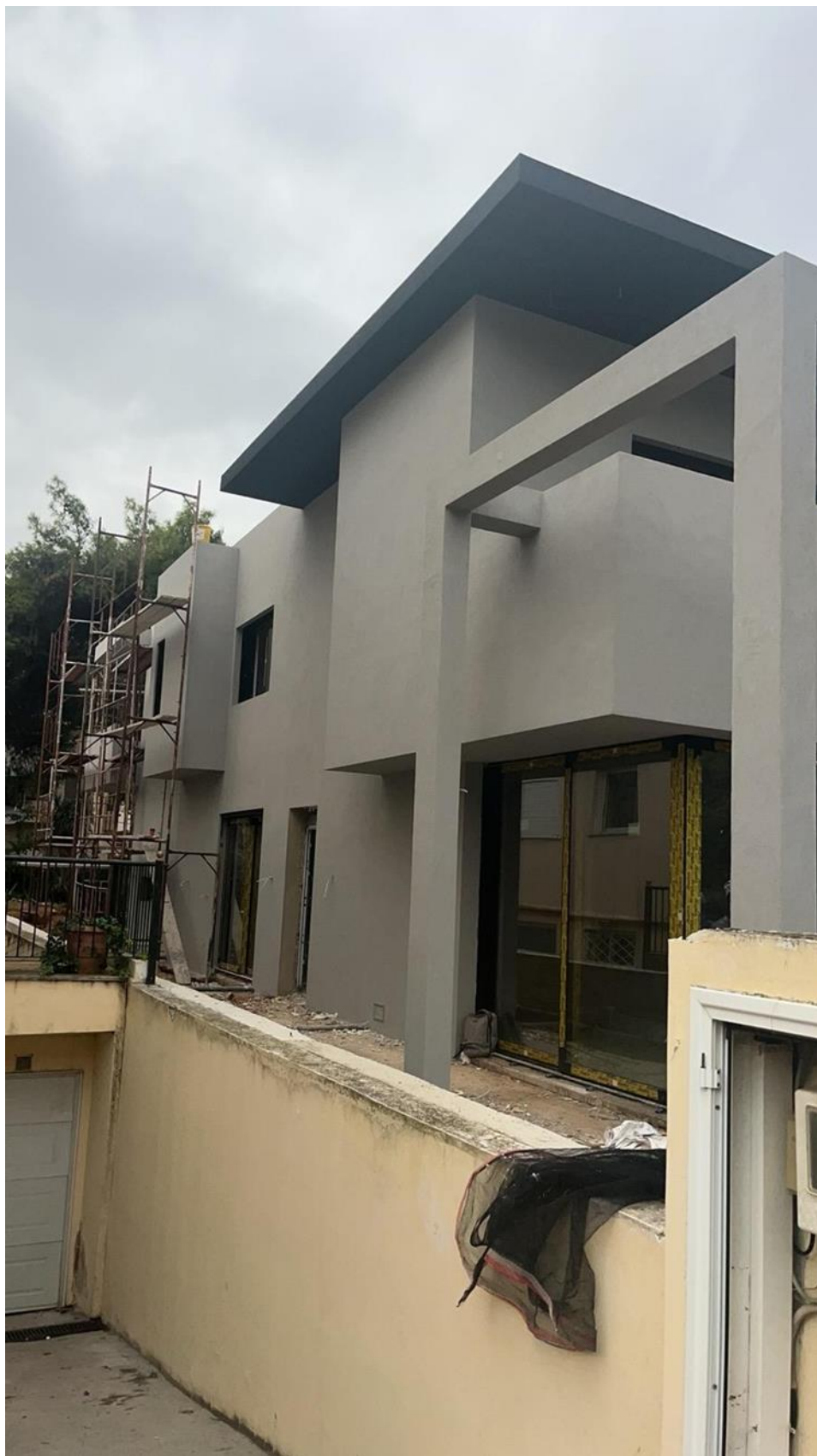
Εικόνα 23. Φωτογραφικό υλικό από την πραγματική κατασκευή #1
