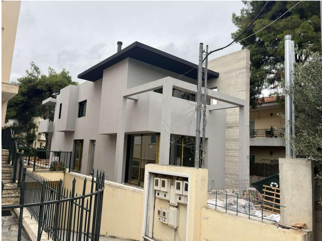
Εικόνα 24. Φωτογραφικό υλικό από την πραγματική κατασκευή #2
