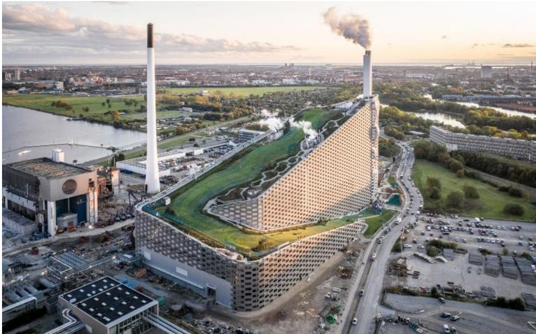
Εικόνα 10-Copenhagen Hill: Εργοστάσιο καύσης απορριμμάτων
