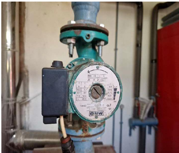
Κυκλοφορητής συστήματος θέρμανσης
