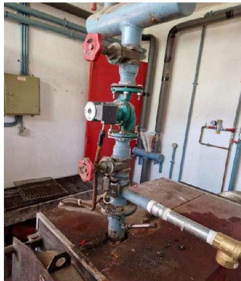
Κυκλοφορητής συστήματος θέρμανσης
