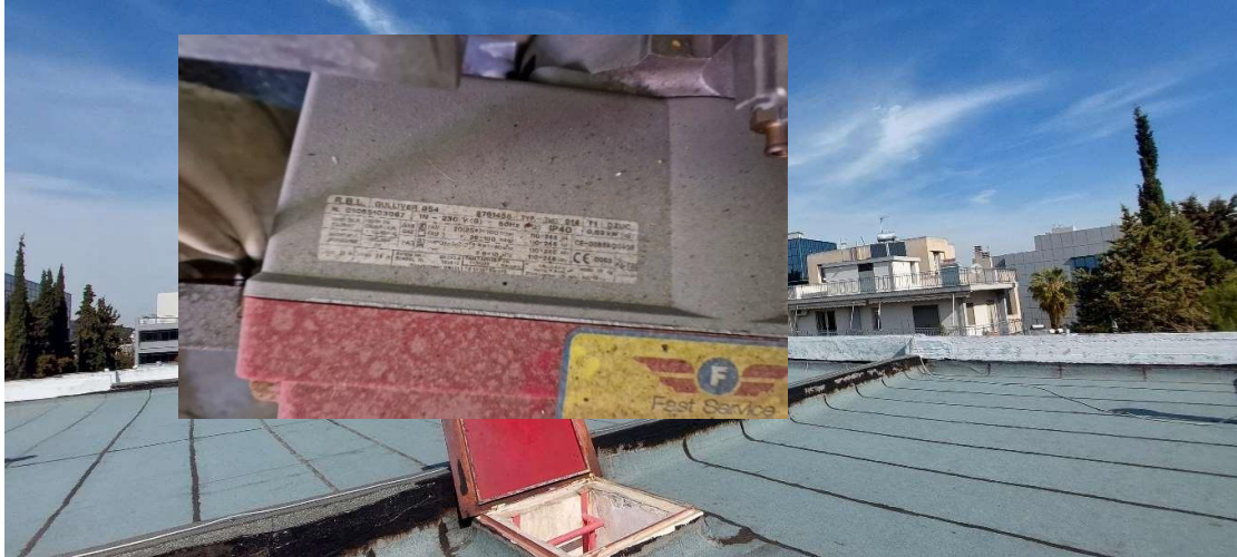
Άποψη του δώματος
