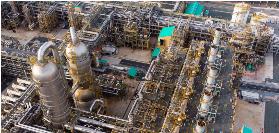
Σχήμα 2.32: Τμήματα εξοπλισμού μονάδας Αναμόρφωσης Νάφθας [55]
