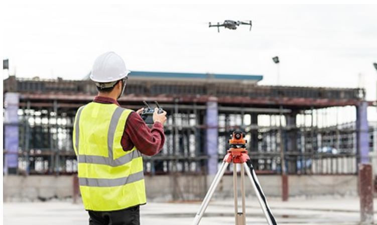
Εικόνα 4 : Χρήση Drone σε κατασκευή (Aimg Official, 2024 )
