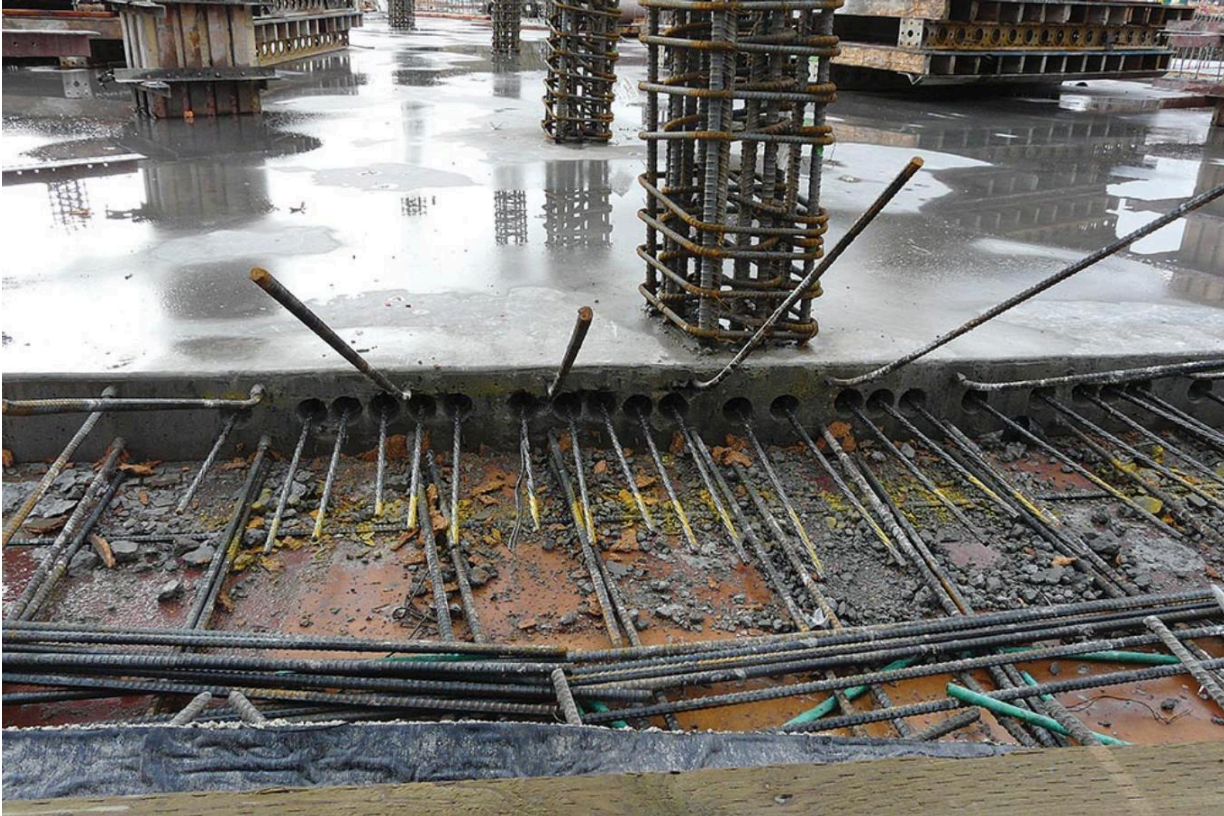
Εικόνα 1. Πλάκες με προένταση μετά τη σκλήρυνση σκυροδέματος (Πηγή: (ΠΛΑΚΕΣ ΜΕ ΠΡΟΕΝΤΑΣΗ ΜΕΤΑ ΤΗ ΣΚΛΗΡΥΝΣΗ ΣΚΥΡΟΔΕΜΑΤΟΣ - ktirio.gr, 2017)
