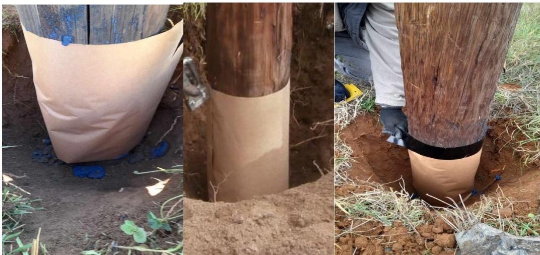
Εικόνα 25 Τοποθέτηση φύλλου κάλυψης και ταινίας επικάλυψης συντηρητικού
