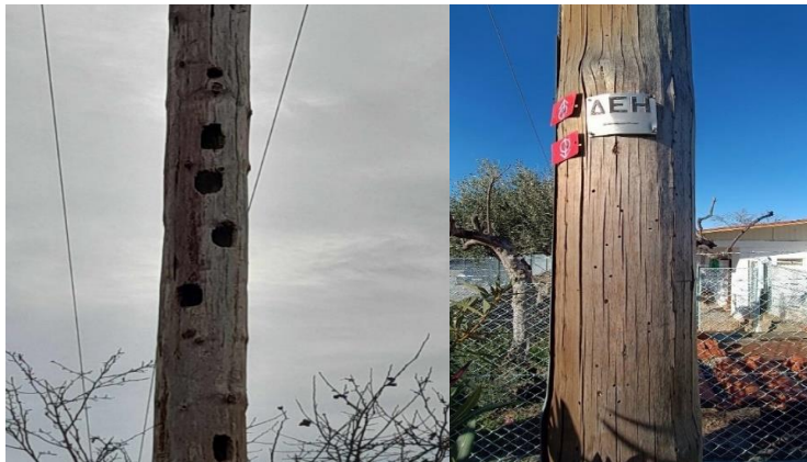
Εικόνα 16 Ζημιά από Δρυκολάπτη (αριστερά) & Ζημιά από σκουλήκι (δεξιά)
