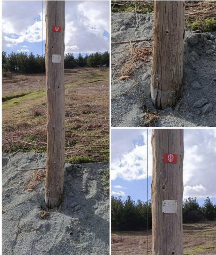
Εικόνα 17 Σήψη και ζημιά ξύλινου στύλου από σκουλήκι
