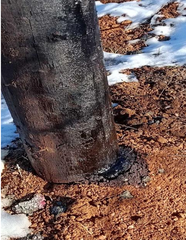
Εικόνα 14 Φαινόμενο Bleeding
