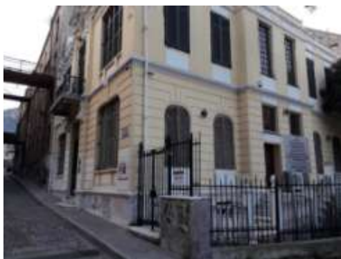
Εικόνα 6: Κτήριο Schinasi (φώτο από Google Earth)
