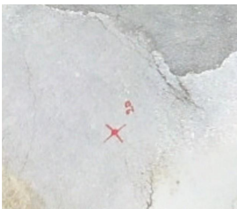
Εικόνα 16 – Φωτοσταθερό Πηγή: Εικόνα από τις εργασίες πεδίου
