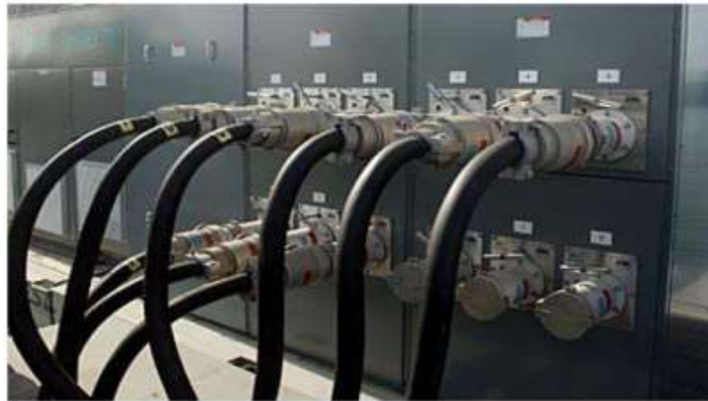
Εικόνα 1.26 : Σύνδεση καλωδίων. [16]
