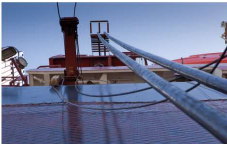
Εικόνα 1.31 : Μεταφορά καλωδίων τροφοδοσίας πάνω στο πλοίο. [16]
