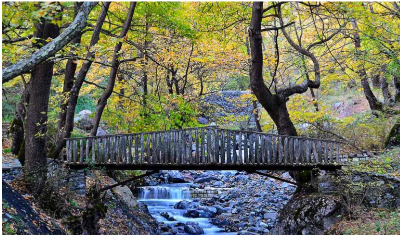
Εικόνα 1.6: Ξύλινη γέφυρα στα Ιωάννινα
