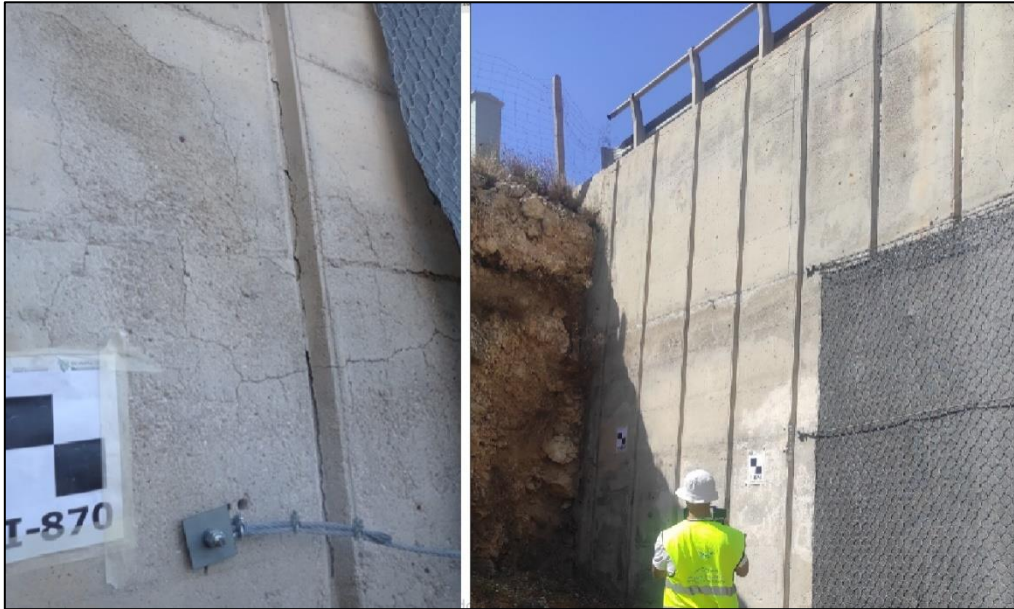
Εικόνα 4.9: Φωτοσταθερά τοποθετημένα επί της γέφυρας
