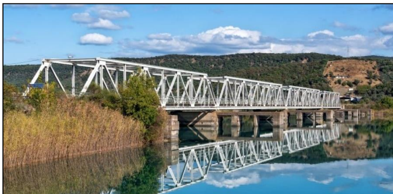
Εικόνα 1.4: Μεταλλική Γέφυρα Μασσουκίου στον Αχελώο
