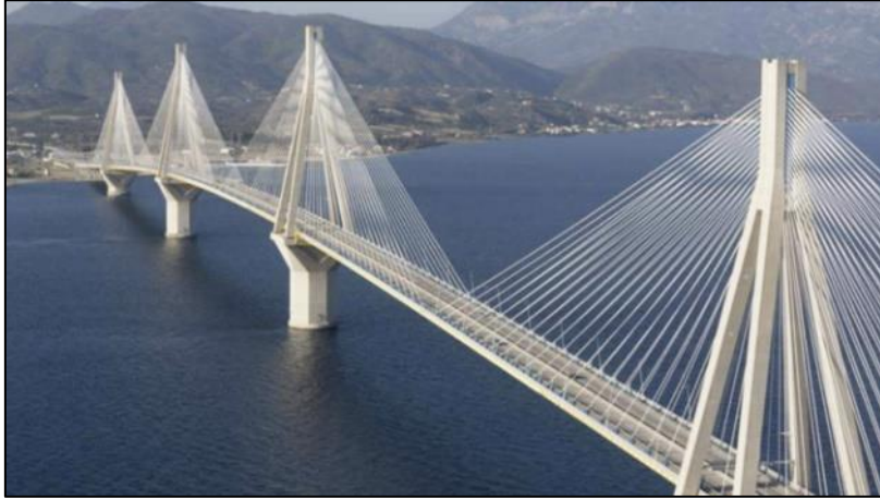
Εικόνα 1.3: Γέφυρα Ρίου Αντιρρίου
