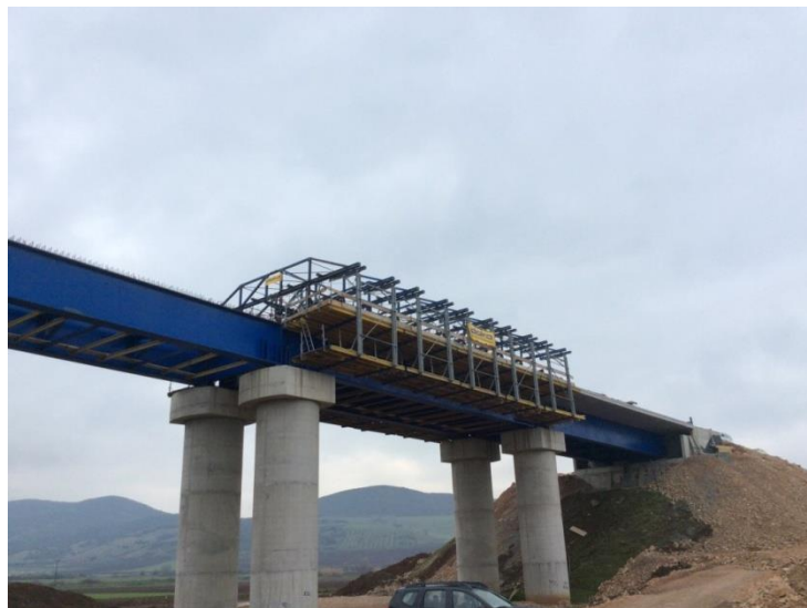
Εικόνα 1.8: Σύμμικτη γέφυρα από δομικό χάλυβα και σκυρόδεμα
