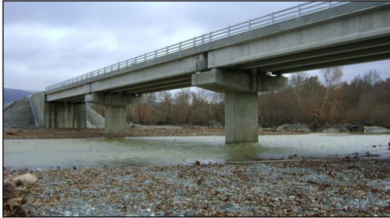
Εικόνα 1.5: Γέφυρα της Εθνικής Οδού από οπλισμένο σκυρόδεμα
