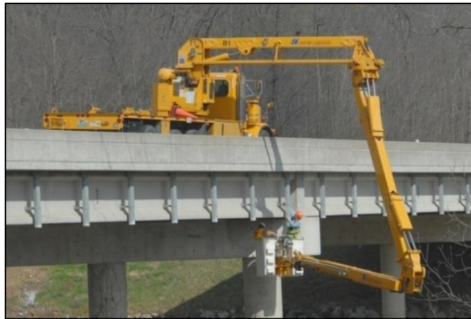
Εικόνα 2.6: Επιθεώρηση γέφυρας με την μέθοδο του οπτικού ελέγχου
