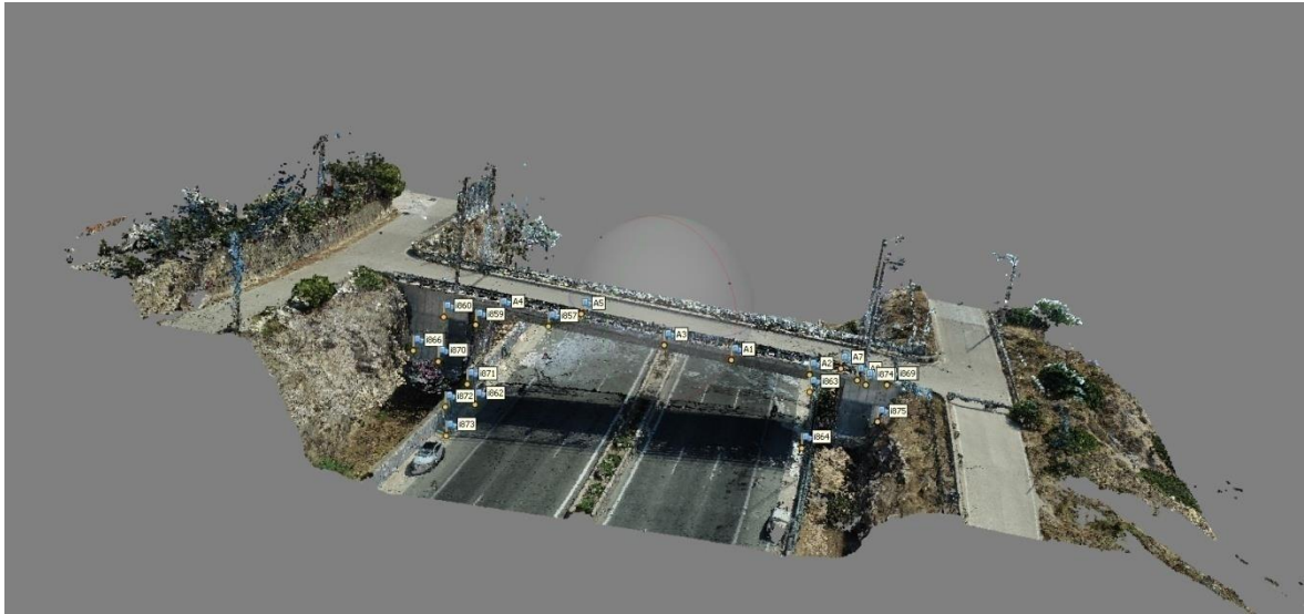
Εικόνα 4.43: Τοποθετημένα φωτοσταθερά επί του αραιού νέφους σημείων
