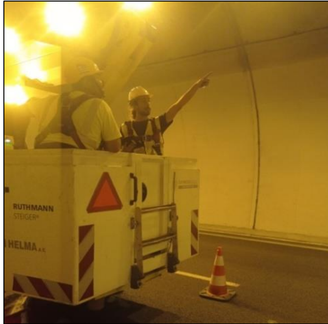
Εικόνα 2.7: Επιθεώρηση σήραγγας με την μέθοδο του οπτικού ελέγχου
