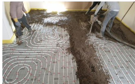
Εικόνα 15: Τοποθέτηση υδραυλικής ενδοδαπέδιας θέρμανσης
