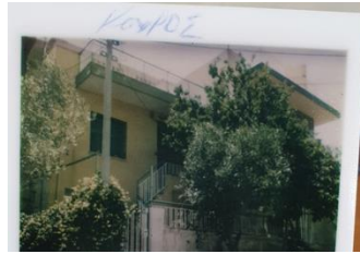
Εικόνα 623: Το υπό μελέτη κτήριο, 1978
