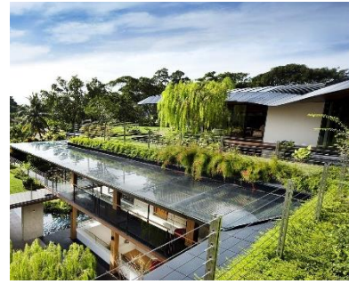
Εικόνα 8: Οικία με δεξαμενή οροφής
