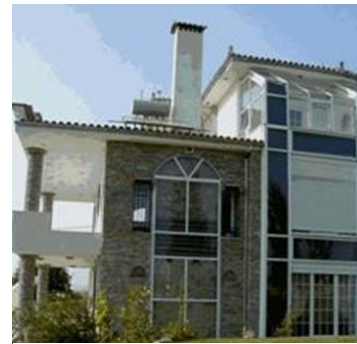
Εικόνα 20: Οικία με ηλιακό τοίχο
