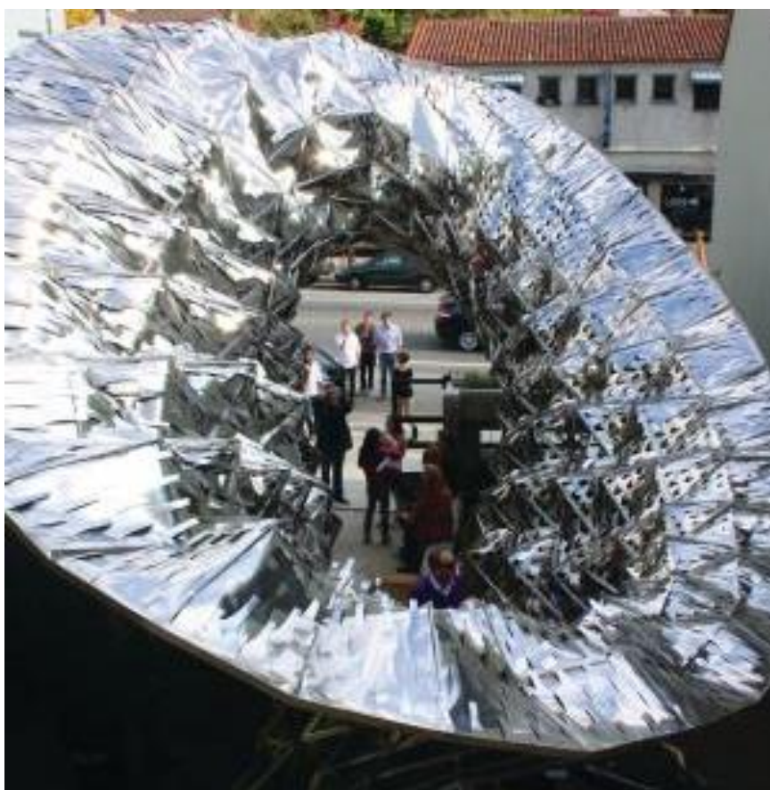
Εικόνα 76: Ευέλικτη επιδερμίδα. Η εγκατάσταση "Bloom" κοντά στο Λος Άντζελες το 2012 έδειξε πώς τα θερμοδιμεταλλικά θα μπορούσαν να ανταποκριθούν στη θερμότητα, στη σκιά ή στον αερισμό ενός κτιρίου. Διαθέσιμο στο:
