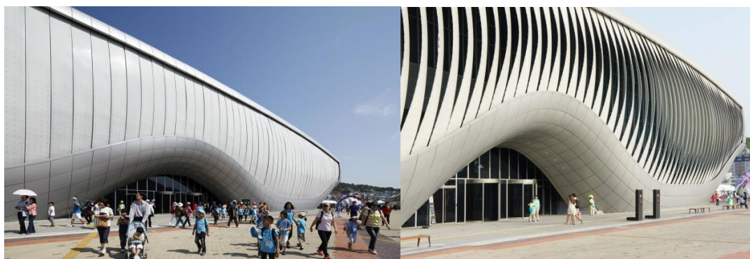
Εικόνες 94. Κινηματική πρόσοψη του θεματικού περιπτέρου EXPO 2012 στο Yeosu, Νότια Κορέα.
