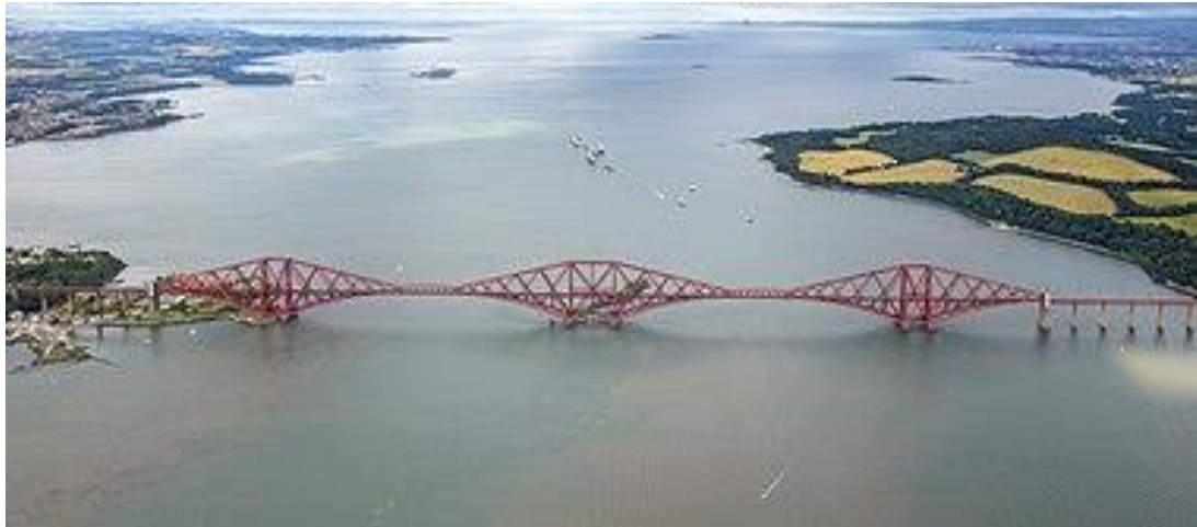
Εικόνα 6: Η γέφυρα σιδηροδρόμων στο Forth
