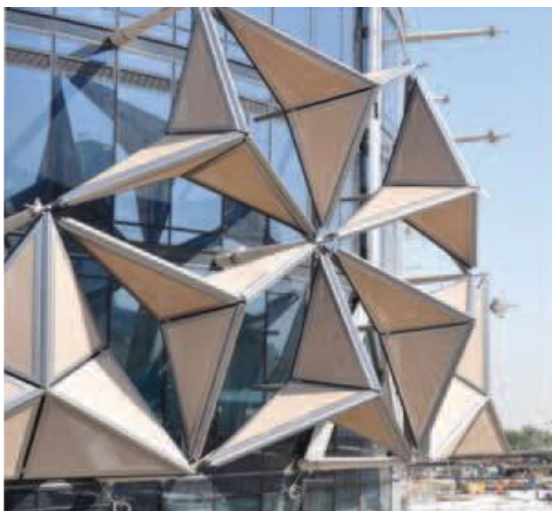
Εικόνα 74: Εφαρμογή θερμοδιμεταλλικού δέρματος σε κτίριο
