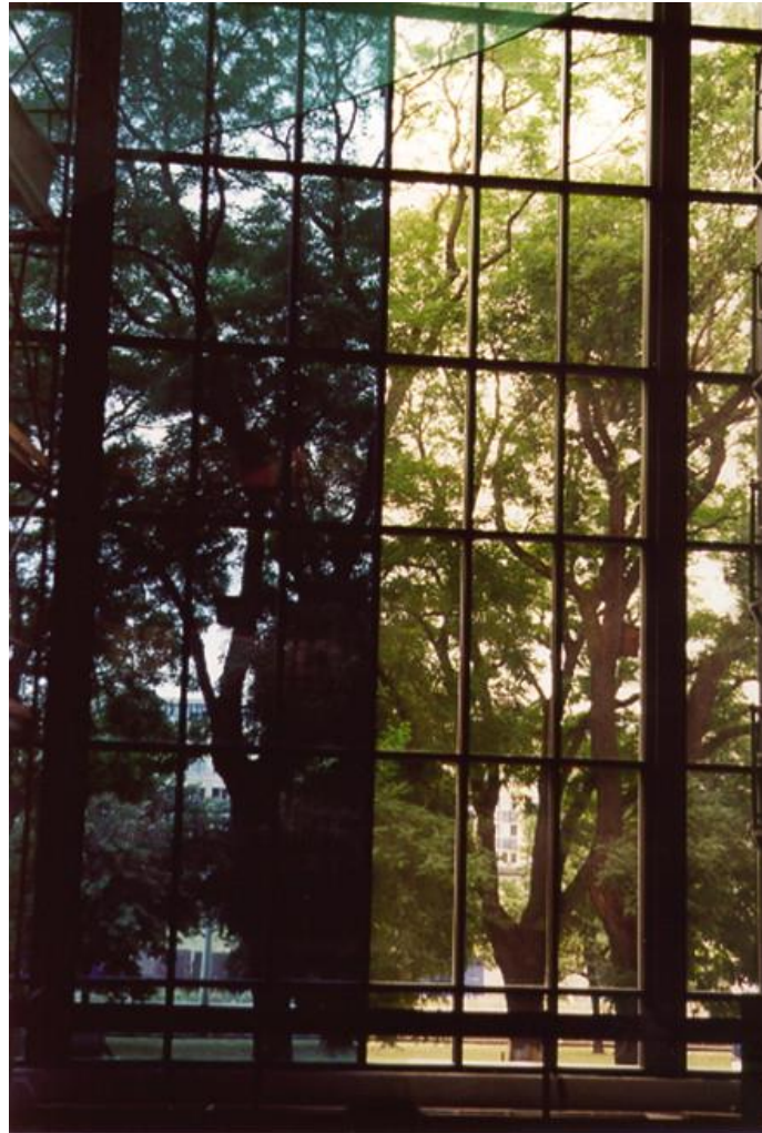
Εικόνα 66: Νότιος προσανατολισμός ενός τμήματος του ηλεκτροχρωμικού γυαλιού E-Control 8 x 17 m κατασκευασμένο από τη Flabeg και εγκατεστημένο στο Stadtparkasse Dresden am Altmarkt. Το αριστερό τμήμα του παραθύρου είναι χρωματισμένο. (Πηγή: Wittkopf, H., Flabeg.)
