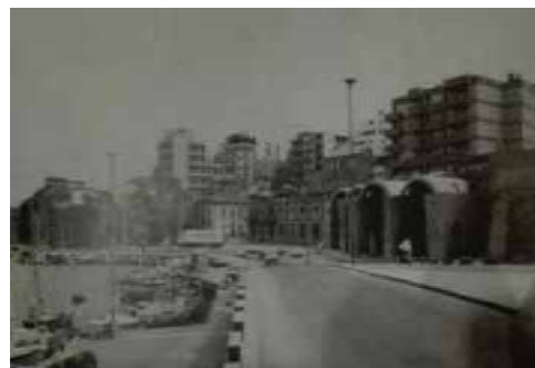
Νοτιοανατολική πλευρά παλαιού λιμένα Ηρακλείου (Τζομπανάκη Χ. ,2000)
