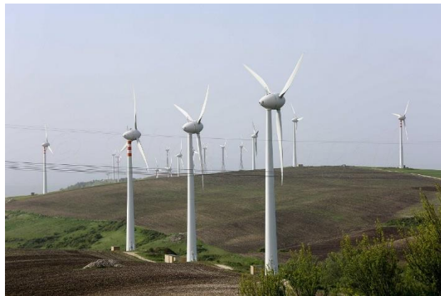
Εικόνα 4-3 Enercon E40 600kW
