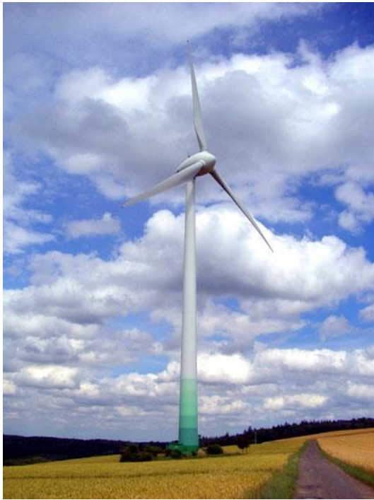
Εικόνα 4-4 Enercon E66 1500kW
