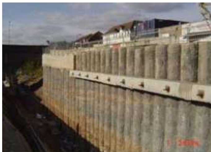
Εικόνα 7: Πάσσαλοι για την παραλαβή οριζόντιων φορτίων (Μπελόκας, 2020)
