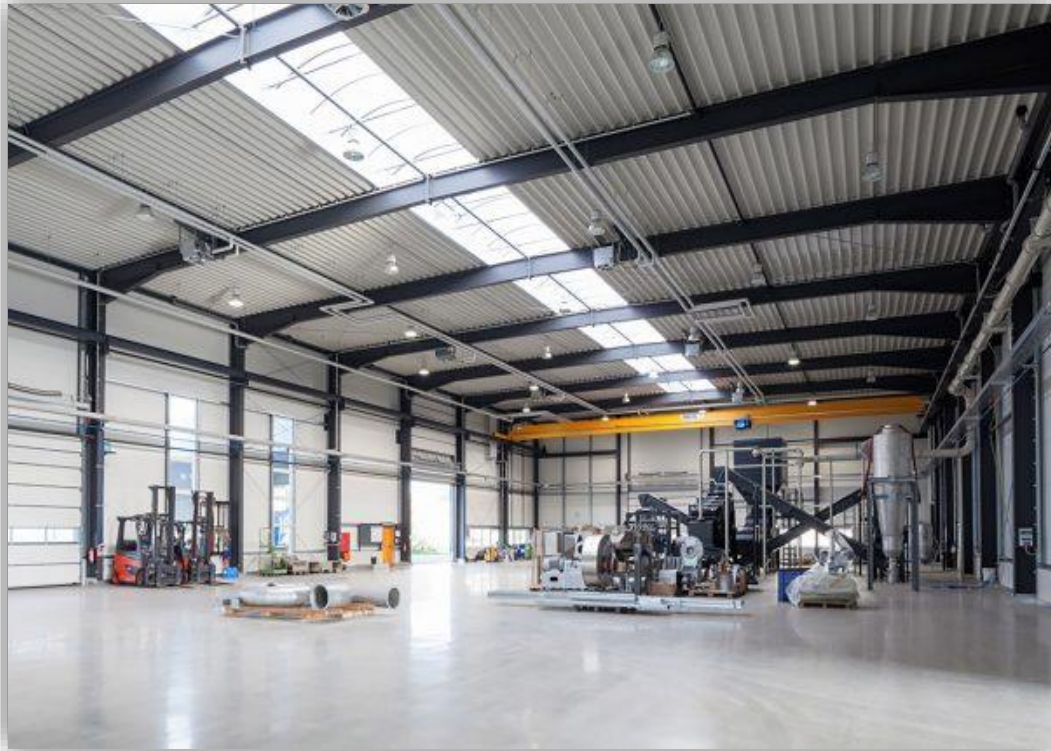
Εικόνα 2.5: Η εγκατάσταση της εταιρίας Accurec για την ανακύκλωση συσσωρευτών λιθίου στο Κρέφελντ στη Γερμανία. Πηγή: Accurec [26]
