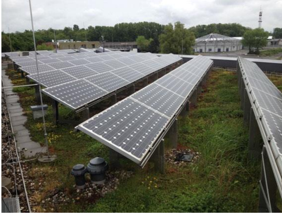
Εικόνα 12 . Φυτεμένο Δώμα και ΑΠΕ (πηγή: https://dynamikiate.gr/ )
