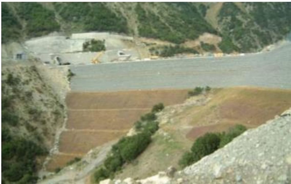
Εικόνα 1.7: Επένδυση εξωτερικής επιφάνειας με MacMat R (πηγή: www.macafferri.com )
