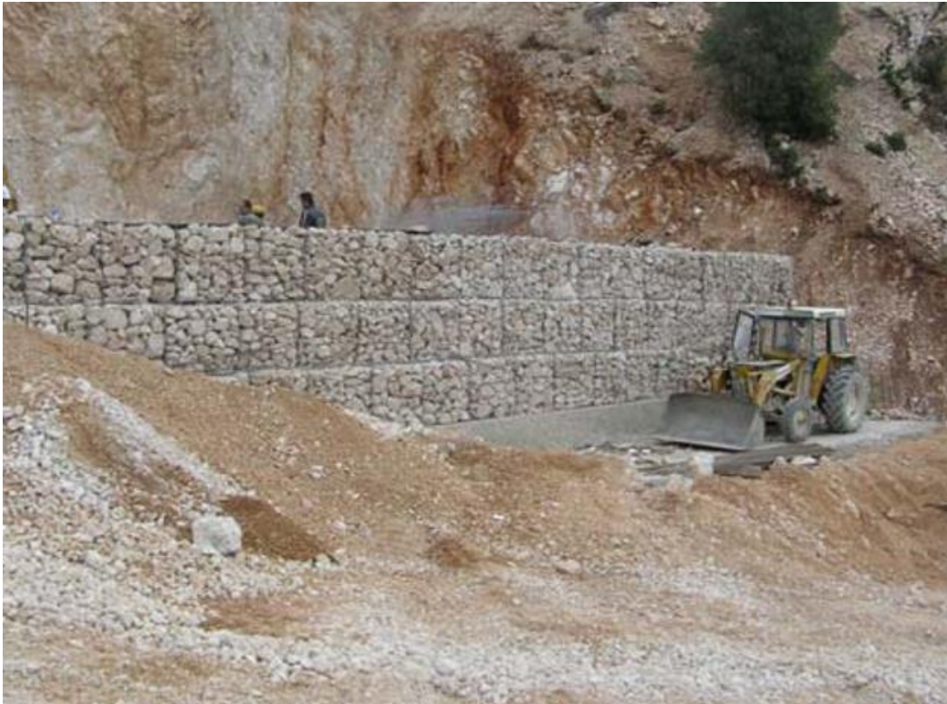
Εικόνα 1.18: Όψη επιχώματος κατά την κατασκευή (πηγή: Εφραιμίδης Χ. Φ.)
