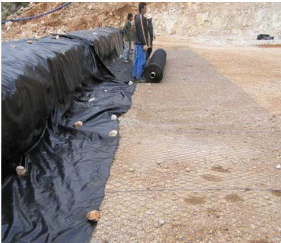
Εικόνα 1.14: Τοποθέτηση 1ου γεωπέγματος (πηγή: Εφραιμίδης Χ. Φ.)
