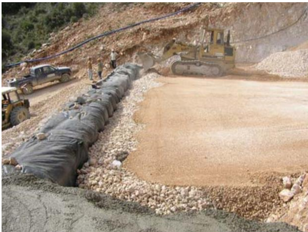
Εικόνα 1.17: Διαστρωση και συμπίκνωση υλικού επίχωσης (πηγή: Εφραιμίδης Χ. Φ.)
