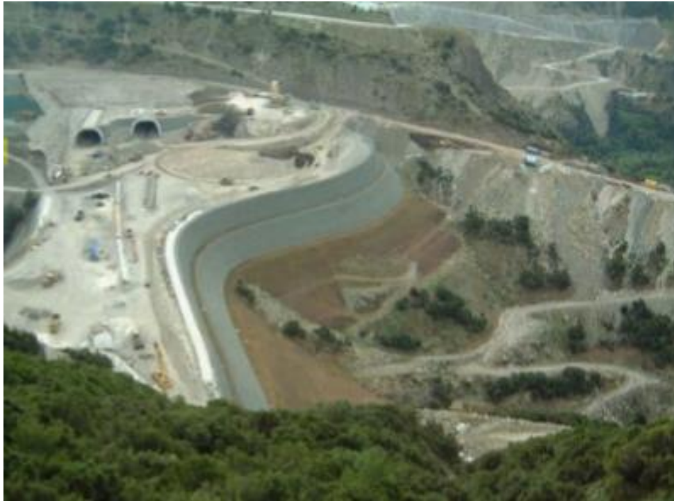
Εικόνα 1.8: Τελικό ύψος επιχώματος (πηγή: www.macafferri.com )
