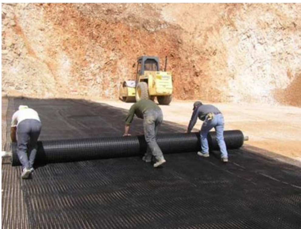
Εικόνα 1.15: Τοποθέτηση 1ου γεωπέγματος (πηγή: Εφραιμίδης Χ. Φ.)
