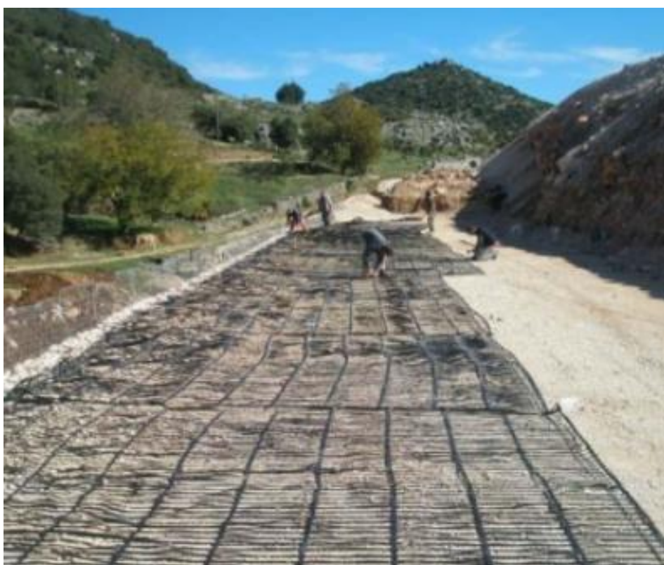
Εικόνα 1.5: Διάστρωση γεωπλέγματος Paralink (πηγή: www.macafferri.com )
