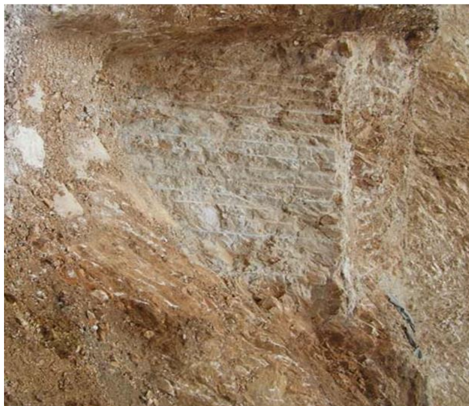
Εικόνα 1.11: Εκσκαφές αναβαθμών ακύρωσης (πηγή: Εφραιμίδης Χ. Φ.)
