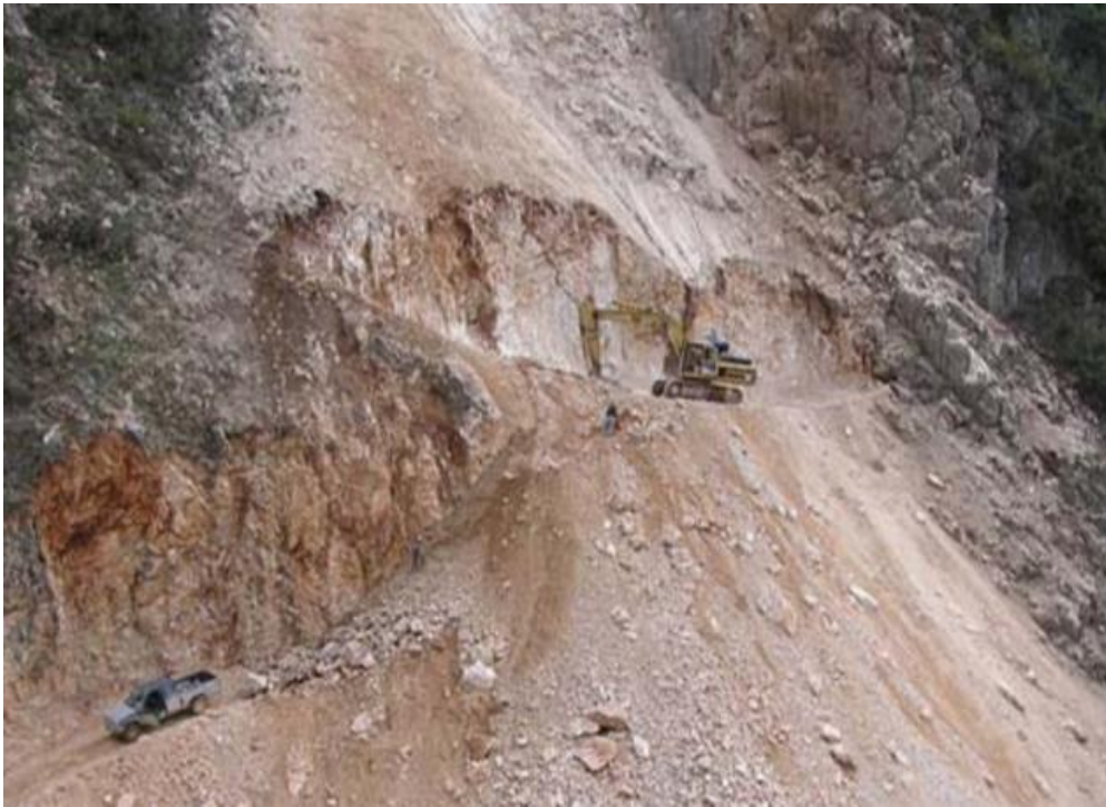
Εικόνα 1.12: Εκσκαφή επιχώματος (πηγή: Εφραιμίδης Χ. Φ.)
