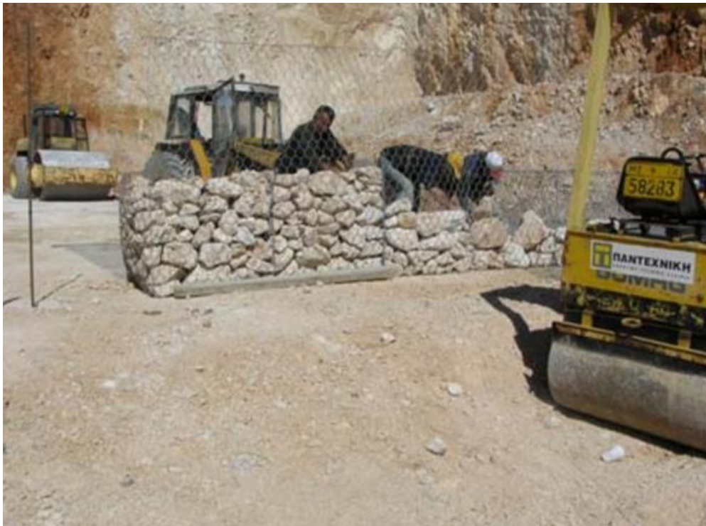
Εικόνα 1.13: Πλήρωση συρματοκιβωτίου (πηγή: Εφραιμίδης Χ. Φ.)
