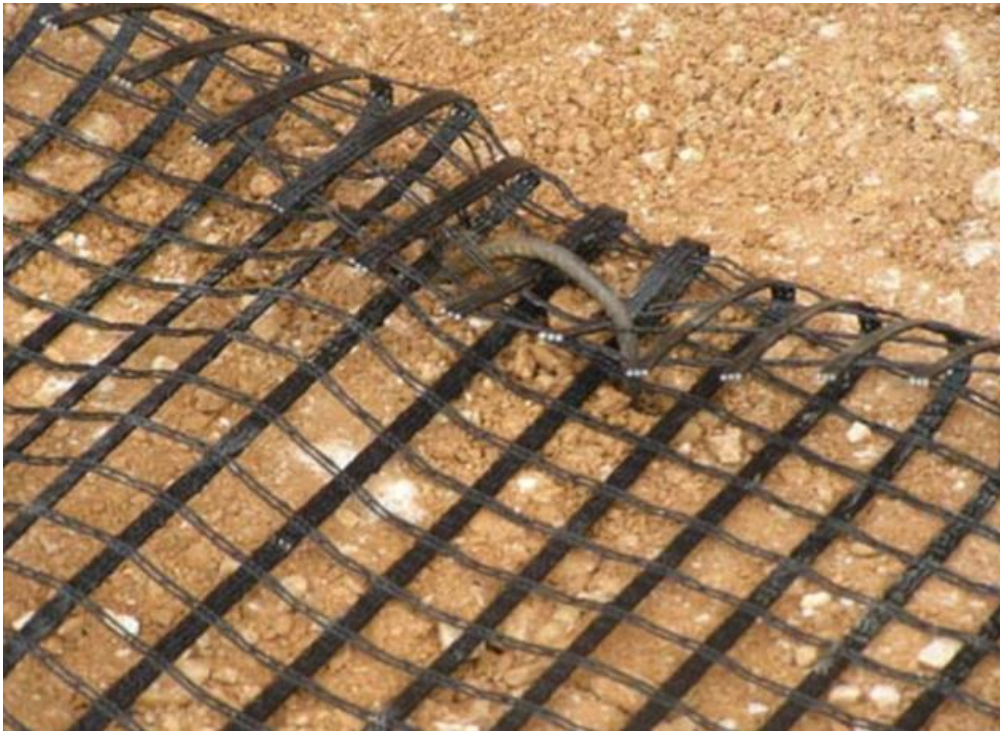
Εικόνα 1.16: Αγκύρωση γεωπλέγματος με σιδηρές ράβδους (J-pin) (πηγή: Εφραιμίδης Χ. Φ.)
