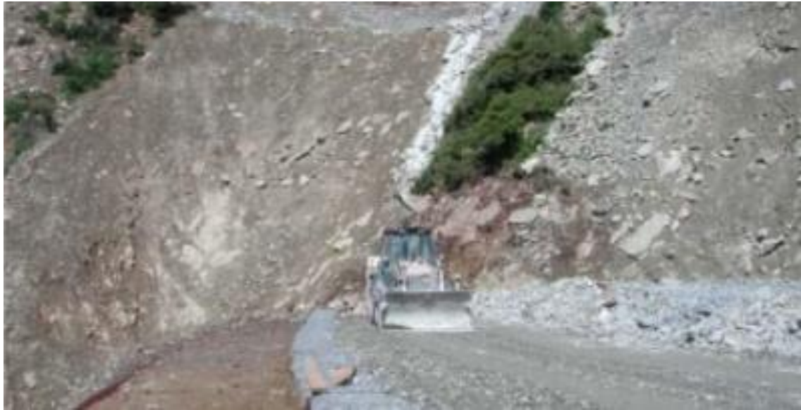
Εικόνα 1.6: Συμπύκνωση ολικού επίχωσης στο γεώπλεγμα Paralink (πηγή: www.macafferri.com )
