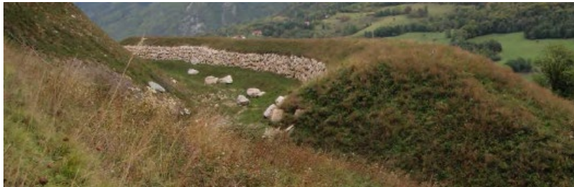
Εικόνα (2.42) Συμβατικό επίχωμα με υποστήριξη λίθων (building.govt.nz)
