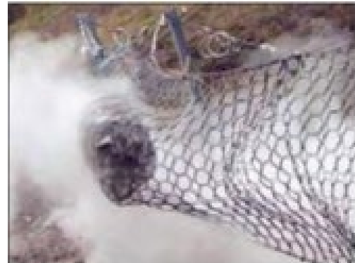
Εικόνα (2.32) Συγκράτηση βράχου από εύκαμπτο φράχτη (Αστερίου, 2016)
