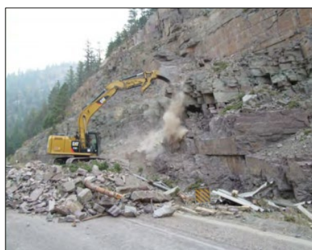
Εικόνα (2.16) Αφαίρεση βράχων με εκσκαφέα (onlinerepubs.trb.org)
