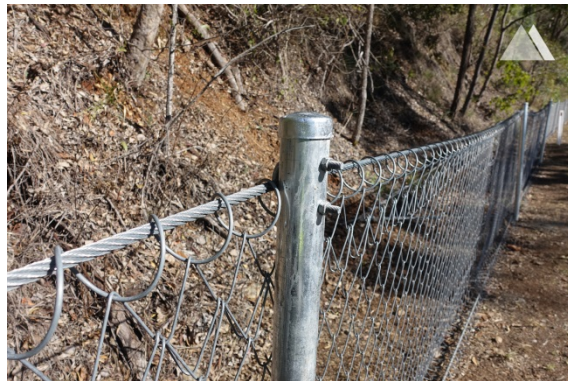
Εικόνα (2.34) Εύκαμπτος φράχτης χωρίς μηχανισμούς απόσβεσης (geobrugg.com)
