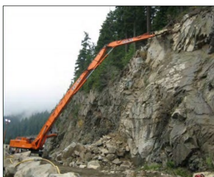
Εικόνα (2.17) Αφαίρεση βράχων με ειδικό εκσκαφέα (onlinerepubs.trb.org)
