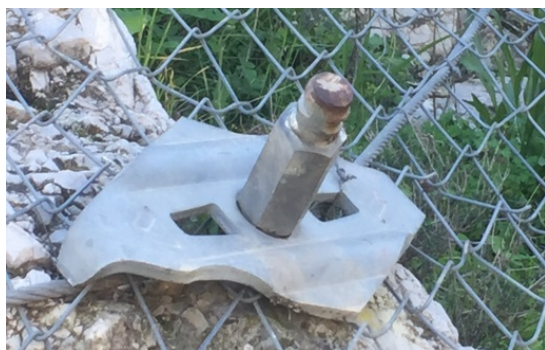
Εικόνα (2.23) Αγκύριο, (Λόφος Σικελίας Καλλιθέα) (Προσωπικό αρχείο)
