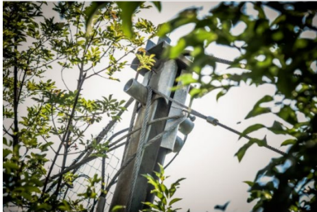
Εικόνα (2.33) Λεπτομέρειες αποσβεστήρων εύκαμπτων φραχτών (geotech.hr)
