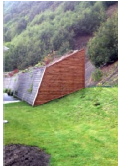
Εικόνα (2.41) Οπλισμένο επίχωμα (building.govt.nz)
