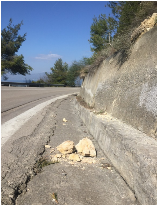
Εικόνα (3.10) Τέμαχος συγκρατημένο σε τάφρο (Μαλακάσα) (Προσωπικό αρχείο)
