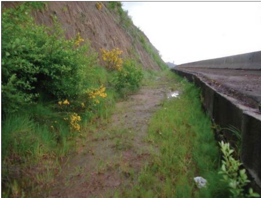
Εικόνα (3.1) Τάφος ανάσχεσης καταπτώσεων (fhwa.dot.gov)
