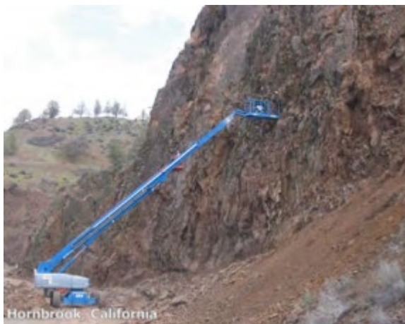
Εικόνα (2.21) Αφαίρεση βράχων από εργάτες με ανυψωτικό μηχάνημα (onlinerpubs.trb.org)
