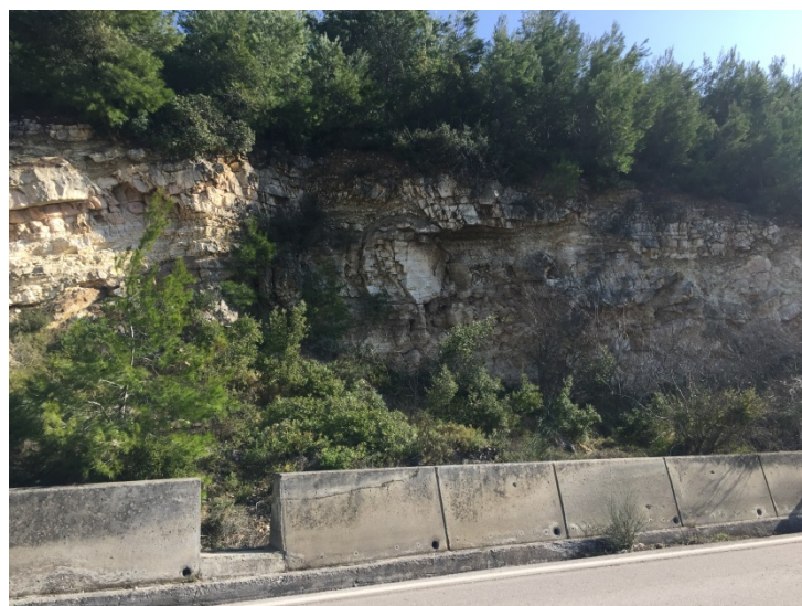
Εικόνα (2.27) Δύσκαμπτος φράχτης και χαντάκι (Μαλακάσα) (Προσωπικό αρχείο)
