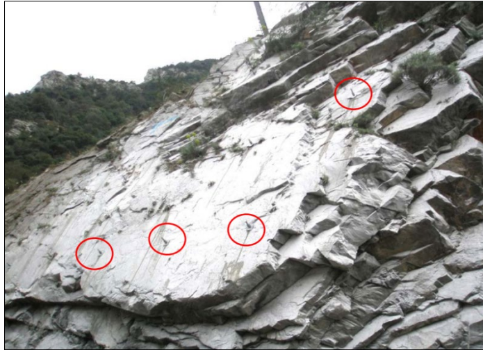
Εικόνα (2.24) Μεγάλος βράχος και αγκύρια υποστήριξης (Αστερίου, 2021)
