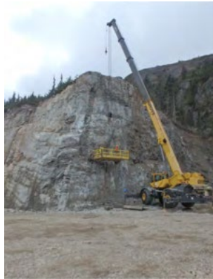
Εικόνα (2.19) Αφαίρεση βράχων από εργάτες με ανυψωτικό μηχάνημα (onlinerpubs.trb.org)
