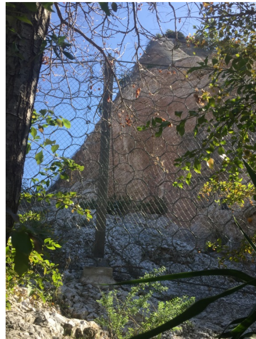
Εικόνα (2.29) Εύκαμπτος φράχτης (Λόφος Σικελίας Καλλιθέα) (Προσωπικό αρχείο)
