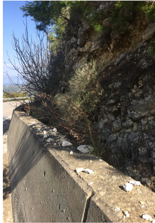
Εικόνα (2.26) Δύσκαμπτος φράχτης (Μαλακάσα) (Προσωπικό αρχείο)
