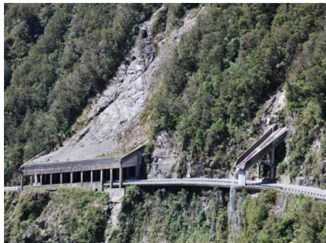
Εικόνα (2.45) Στέγαστρο καταπτώσεων (Αστερίου, 2021)
