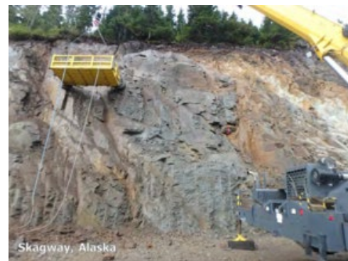
Εικόνα (2.22) Αφαίρεση βράχων από εργάτες με ανυψωτικό μηχάνημα (onlinerpubs.trb.org)
