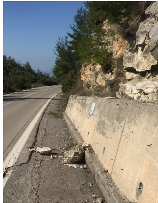
Εικόνα (3.9) Τέμαχος συγκρατημένο σε τάφρο (Μαλακάσα) (Προσωπικό αρχείο)
