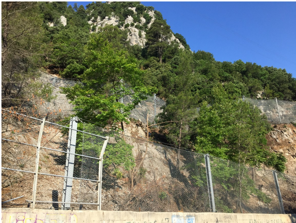
Εικόνα (7.7) Πολλαπλά μέτρα προστασίας. Φράχτης σκυροδέματος, μεταλλικοί φράχτες, και τάφρος. (ΕΟ Χαλκίδας – Αιδηψού) (Προσωπικό αρχείο)
