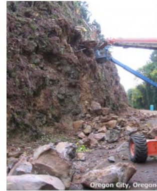
Εικόνα (2.20) Αφαίρεση βράχων από εργάτες με ανυψωτικό μηχάνημα (onlinerpubs.trb.org)
