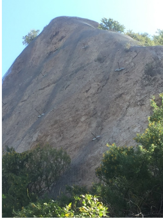
Εικόνα (2.38) Μεταλλικό πλέγμα με αγκύρια (Λόφος Σικελίας Καλλιθέα) (Προσωπικό αρχείο)
