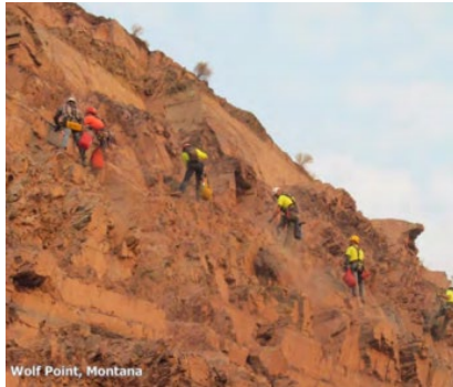
Εικόνα (2.18) Αφαίρεση βράχων από εργάτες με σχοινιά (onlinerpubs.trb.org)
