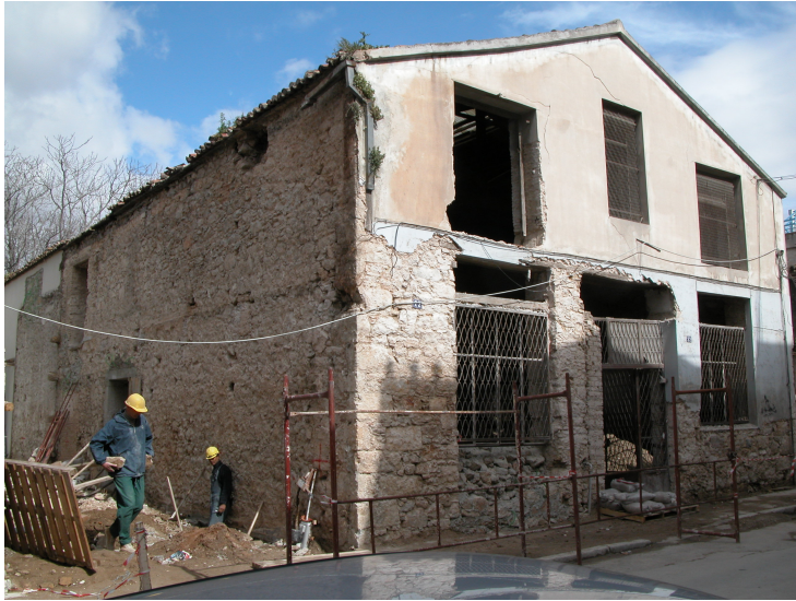
Εικόνα 26 - Άποψη Κτιρίου Μελέτης
