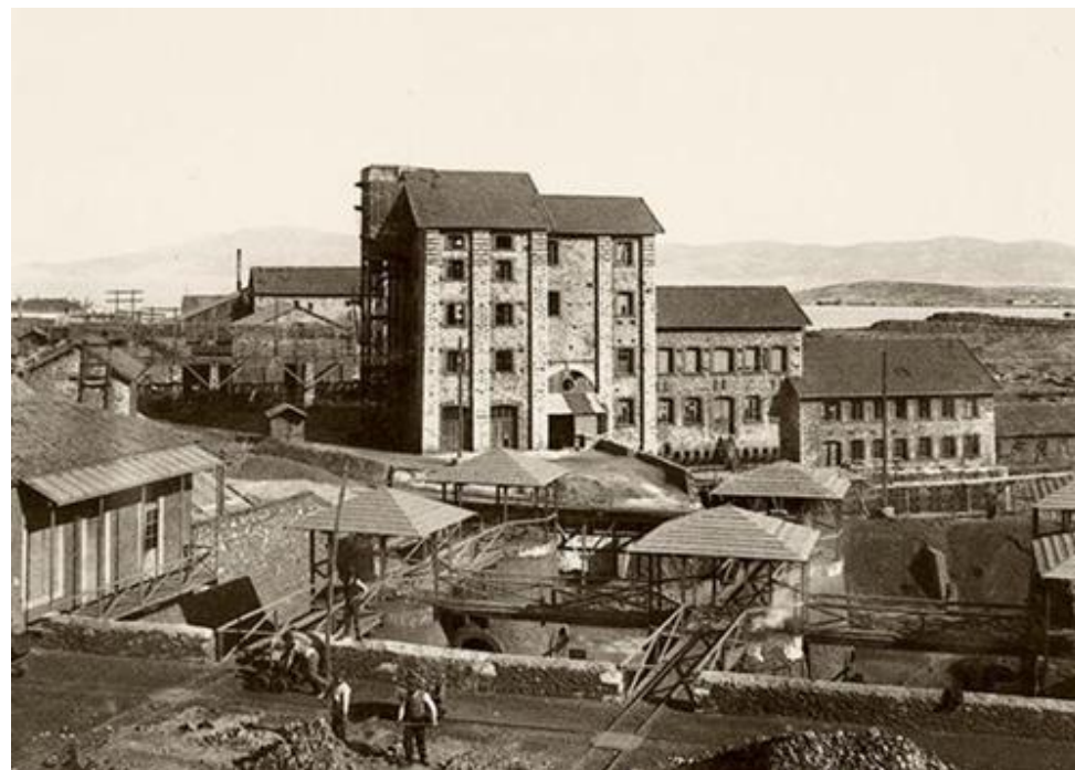
Εικόνα 19 - Τμήμα παραγωγής πυρωμένης καλαμίνας (ψευδαργυρούχο μετάλλευμα) που μετέπειτα γίνεται ζυλουργείο και υποσταθμός ηλεκτρικού ρεύματος της Γαλλικής Εταιρείας Μεταλλείων Λαυρίου
