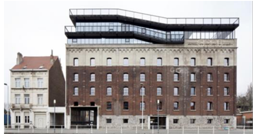
Εικόνα 10 – Coop project (adaptive re-use) , Βρυξέλλες
