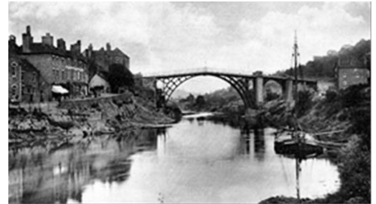
Εικόνα 4 - Η Γέφυρα Ironbridge στα ορυχεία Shropshire, 1779
