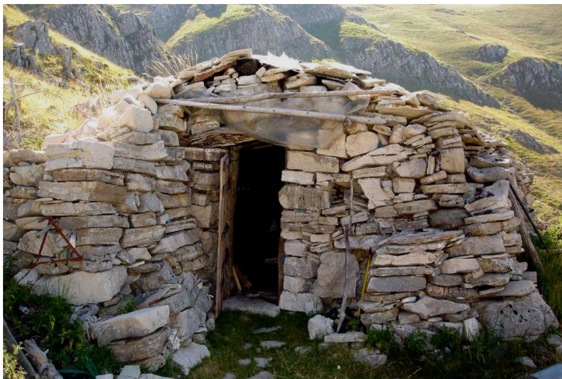
Εικόνα 5. Βλαχική Καλυβα Κτηνοτρόφων της Πίνδου, Πηγή: https://www.vlahoi.net/articles?start=320 , ημ.ανάκτησης 13/08/21
