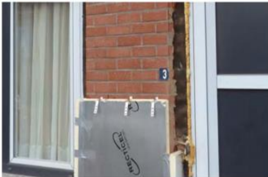
Εικόνα 34: Εξωτερική θερμομόνωση υφιστάμενων κτιρίων στο Βέλγιο. Πηγή: ΙΕΑ 2010 9
