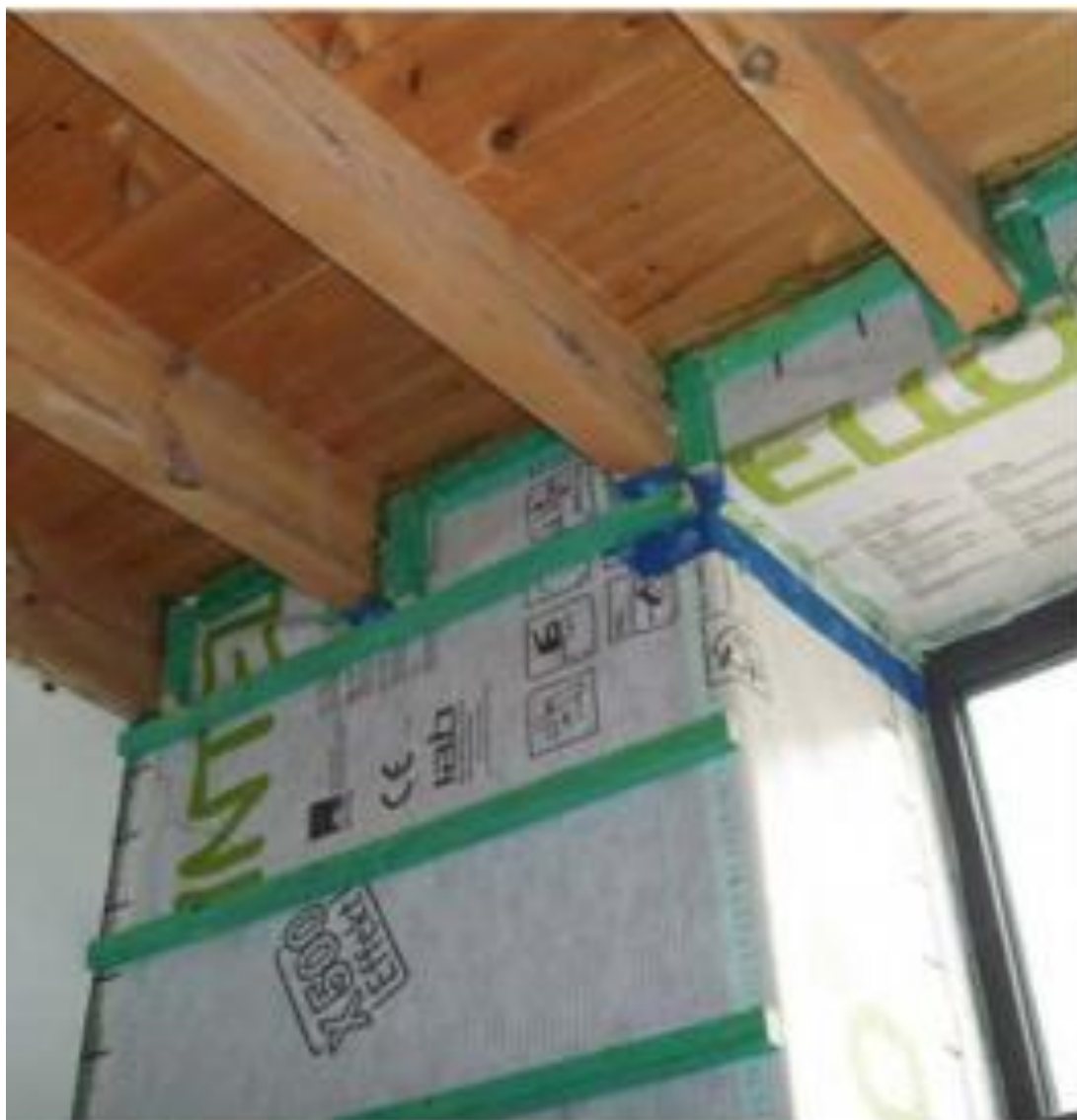
Εικόνα 30: Μικρή ανακαίνιση στην εσωτερική μόνωση ενός κτιρίου. Πηγή: International Energy Agency 2010 9
