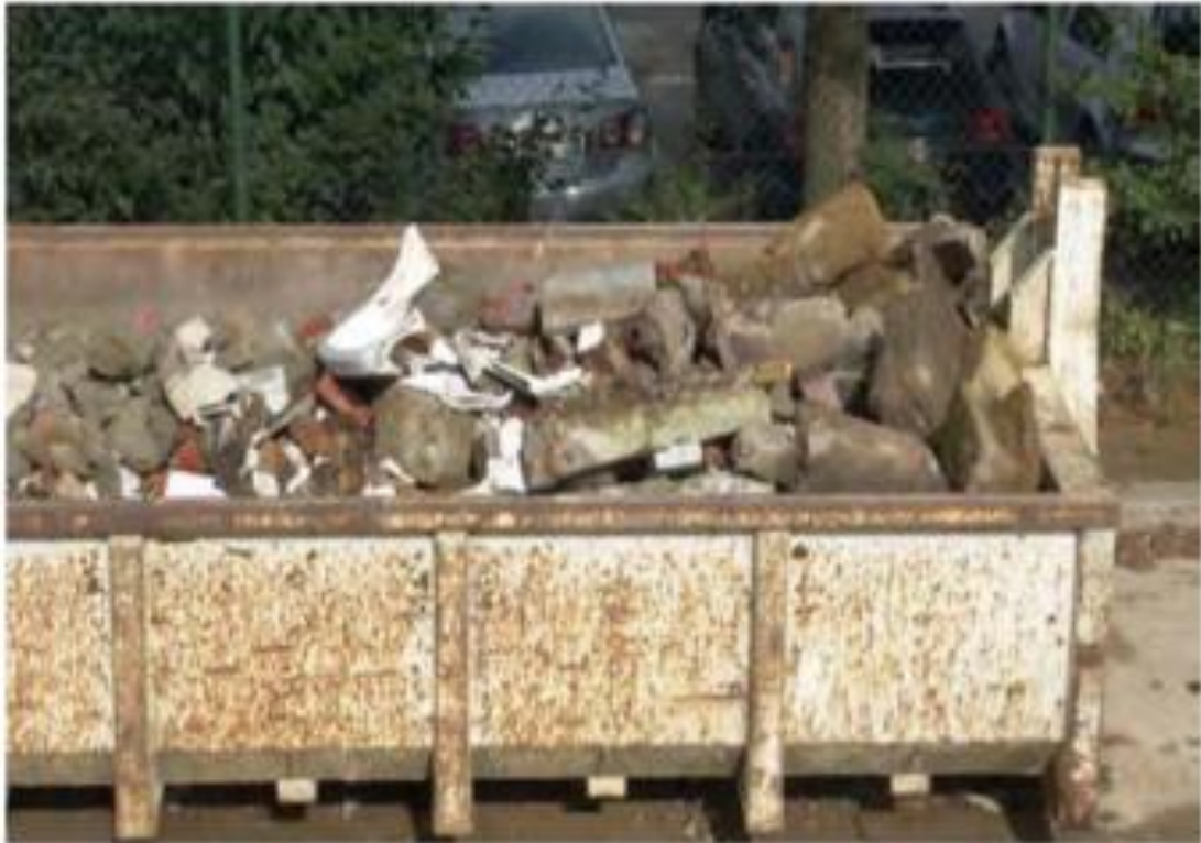
Εκόνα 32: Κοντέινερ απόθεσης αποβλήτων σκυροδέματος. Πηγή: Πράσινη ανακαίνιση: Η Περίπτωση των αστικών κατοικιών, Βασιλειάδου Χριστίνα, Φεβρουάριος 2016 9
