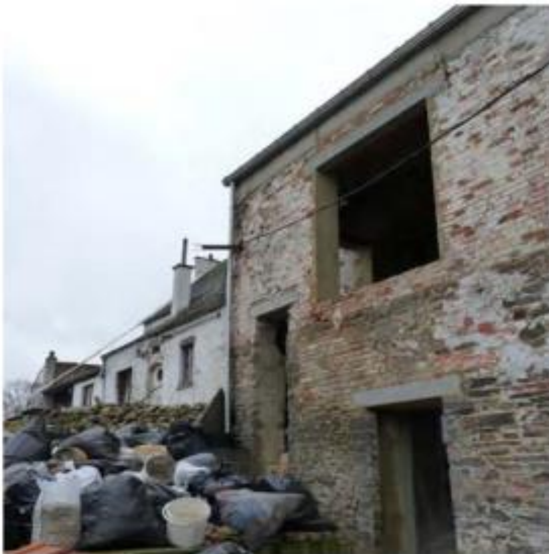
Εικόνα 29: Μεγάλη ανακαίνιση κτιρίου. Πηγή: International Energy Agency 2010 9
