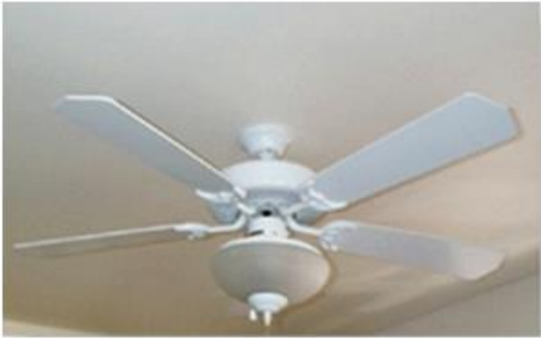
Εικόνα 15: Υβριδικός αερισμός με χρήση ανεμιστήρα οροφής. Πηγή: http://www.cres.gr/energy_saving/Ktiria/fysikos_drosismos_ybridikos_aerismos.htm
