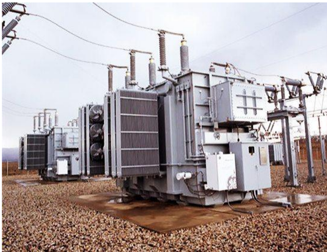
Εικόνα 1.4: Μετασχηματιστές διανομής
