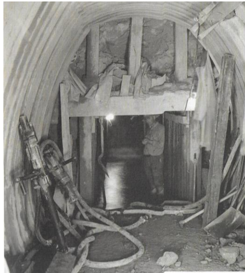
Εικόνα 6: Κατασκευή σήραγγας Μπογιατίου 1927, Από το λεύκωμα « Ο κύκλος του νερού στην Αττική γη» της ΕΥΔΑΠ
