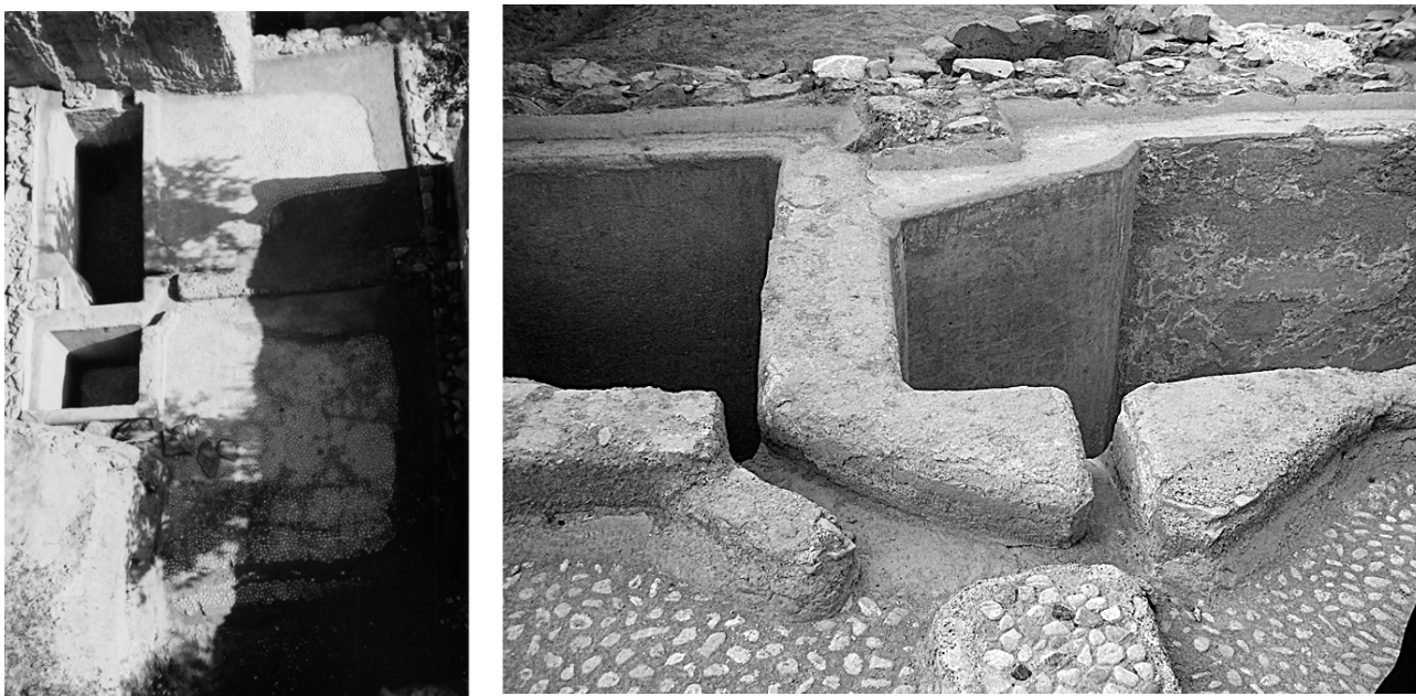
Εικ.19, 20 (Αριστ): Άποψη του συστήματος των τεσσάρων δεξαμενών. (Δεξιά): Τα κανάλια που συνέδεαν τις δεξαμενές μεταξύ τους (από Katsonopoulou 2011a)
