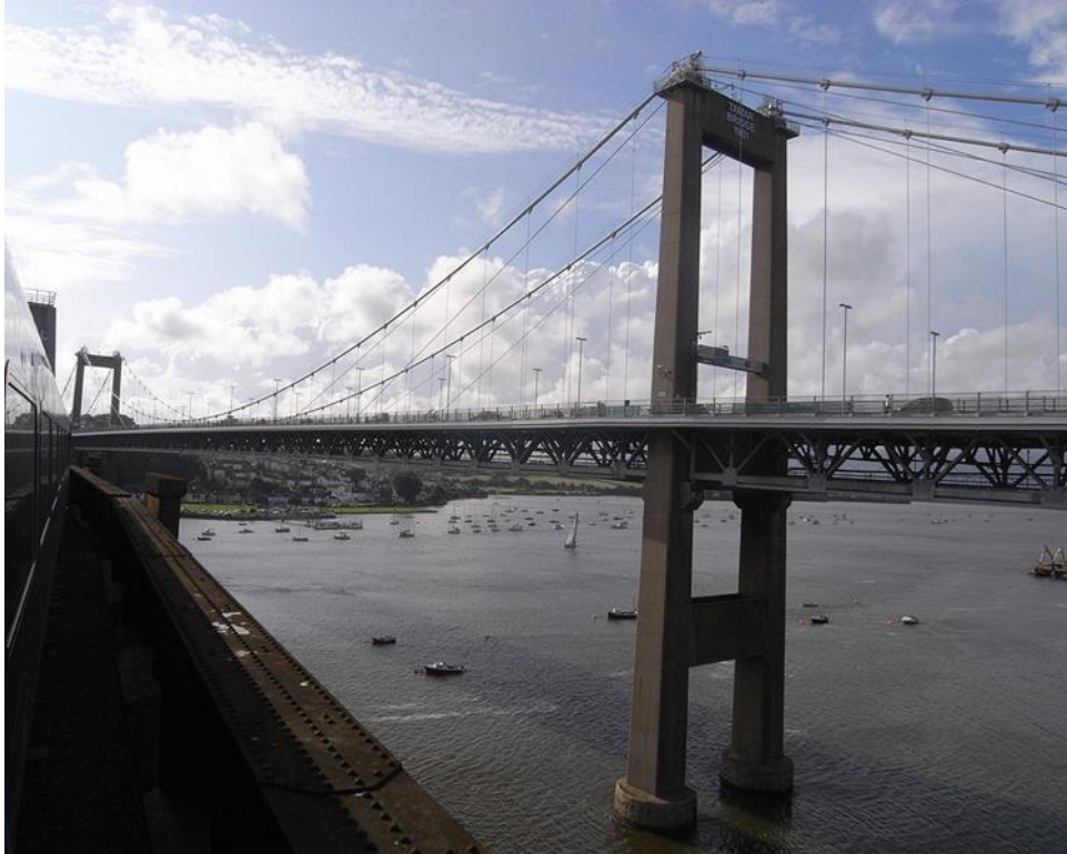
Εικόνα 12 - Tamar Bridge UK
