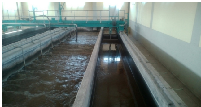
Εικόνα 4.9 Αεριζόμενος Εξαμμωτής – Απολιπαντής (εικόνα ΚΕΛΘ)
