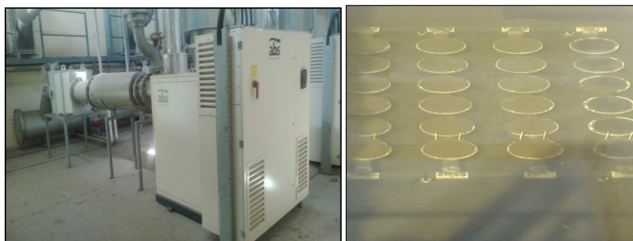
Εικόνα 4.18 Φυσητήρας - Σύστημα διάχυσης με μεμβράνες (εικόνα ΚΕΛΘ)
