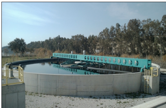
Εικόνα 4.19 Τελική καθίζηση (εικόνα ΚΕΛΘ)
