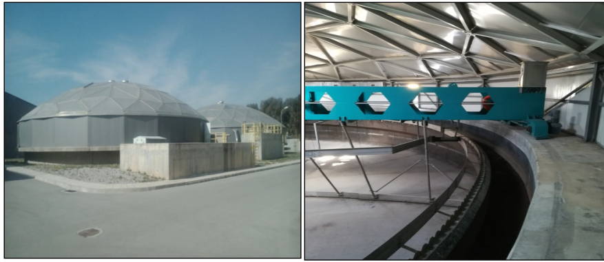
Εικόνα 4.13 Πρωτοβάθμια Καθίζηση (εικόνα ΚΕΛΘ)
