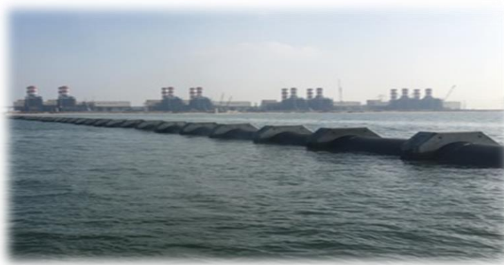
Σχήμα 4.2: Ερματωμένος αγωγός από HDPE μήκους 1.2 km στη Αίγυπτο το 2018 (πηγή https://www.makai.com/pipelines/ )
