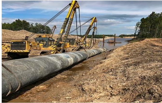
Σχήμα 4.4: Τράβηγμα αγωγού στη θάλασσα (πηγή https://www.aosgm.com/press/photo/crossing-the-volkhov/ )
