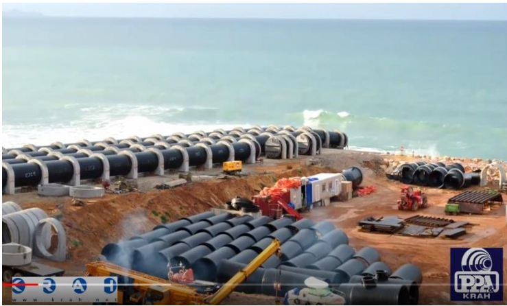
Σχήμα 4.10γ: Προετοιμασία του αγωγού πριν την πόντιση στη περιοχή Koudiet, Algeria
