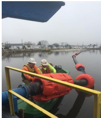
Σχήμα 4.7: Τοποθέτηση κολάρων πλεύσης (πηγή https://pipefloat.com/pipe-float )
