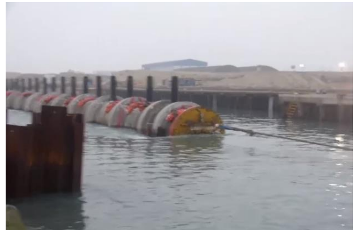
Σχήμα 4.10δ: Τράβηγμα του αγωγού στο βυθό της θάλασσας στη πόλη Lima, Peru
