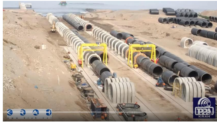
Σχήμα 4.10β: Συγκόλληση και ερμάτωση τεμαχίων στη πόλη Lima, Peru
