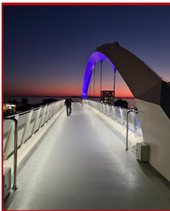
Εικόνα 1 Πεζογέφυρα Αλίμου , "ΣΤΑΘΗΣ ΚΟΚΚΙΝΗΣ ΚΑΤΑΣΚΕΥΑΣΤΙΚΗ 2020 ΑΕ"
