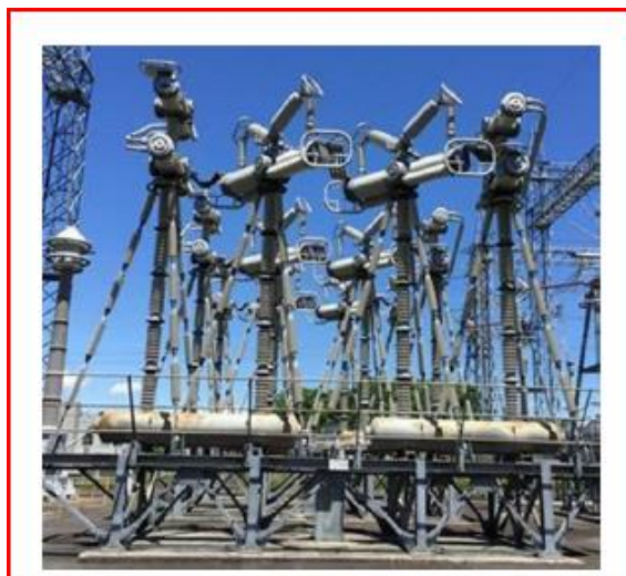
Σχήμα 3.2 Διακόπτες Αέρα [6]
