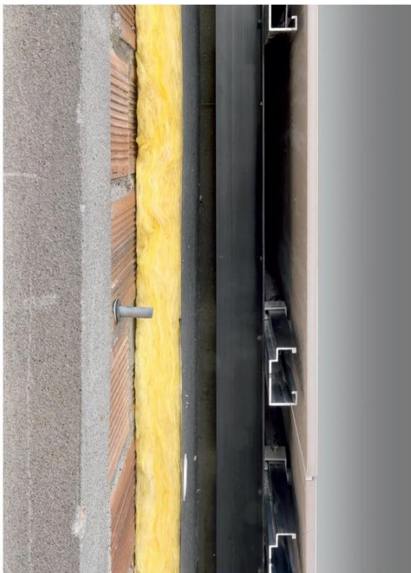
Εικόνα 7: Πλάγια όψη συστήματος αεριζόμενου τοίχου. [30]
