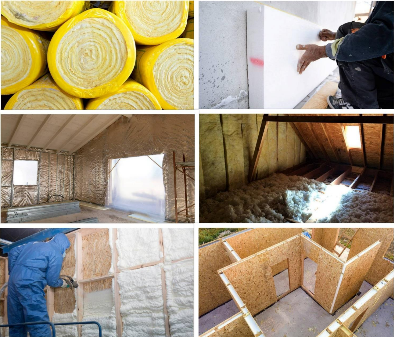
Εικόνα 18: Είδη μονώσεων. Από πάνω αριστερά προς κάτω δεξιά: Ρολό μόνωσης, Σκληρή πλάκα (rigid board), ανακλαστική μόνωση (reflective insulation), μόνωση χαλαρής πλήρωσης (loose-fill/blow-in), εκτοξευόμενος αφρός (spray foam), δομικά μονωμένα πάνελ (Structural Insulated Panels (SIPs) [49]
