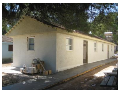
Εικόνα 13 Εργασίες ανακαίνισης οικίσκου Μύκονος- Αποδυτήρια (2019) Πηγή : Δ/ση Κτιριακής Υποδομής
