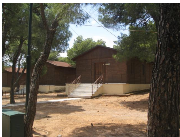
Εικόνα 109 Υπάρχουσα κατάσταση ξύλινων θαλάμων (2019) Πηγή : Προσωπικό αρχείο
