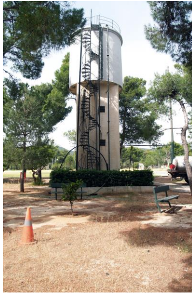
Εικόνα 27 Υδατόπυργος (2017) Πηγή: Καίσαρη Βικτωρία
