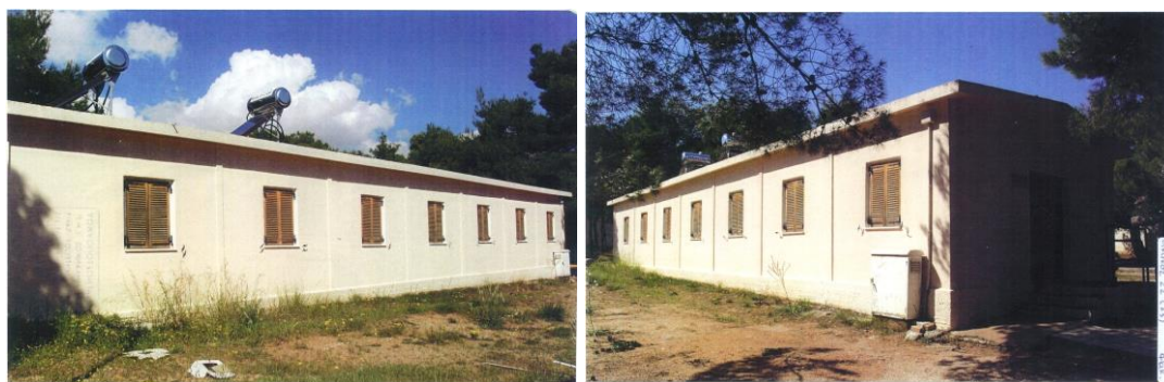
Εικόνες 54, 55 Πλάγια όψη και είσοδος στους οικίσκους «Ανδρος», «Σάμος» (2006) Πηγή : Δ/νση Κτιριακής Υποδομής Δήμου Αθηναίων
