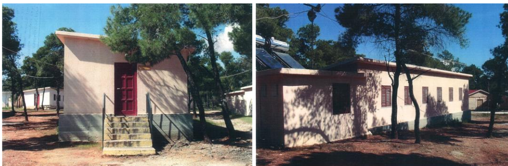
Εικόνες 84, 85 Είσοδος και πλάγια όψη στον οικίσκο «Εύηνος» (2006) Πηγή : Δ/ση Κτιριακής Υποδομής Δήμου Αθηναίων
