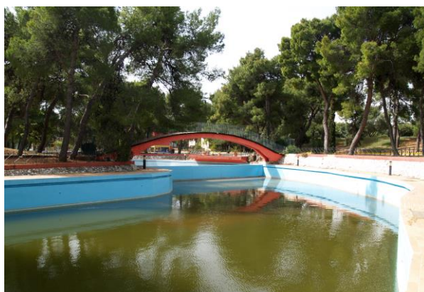
Εικόνα 32 Δεξαμενή πυρόσβεσης (2020) Πηγή : Προσωπικό αρχείο
