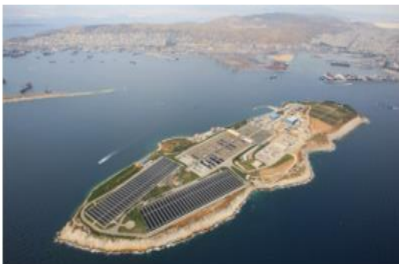
Εικόνα 19. Κέντρο επεξεργασίας λυμάτων Ψυττάλειας. Πηγή: [70]
