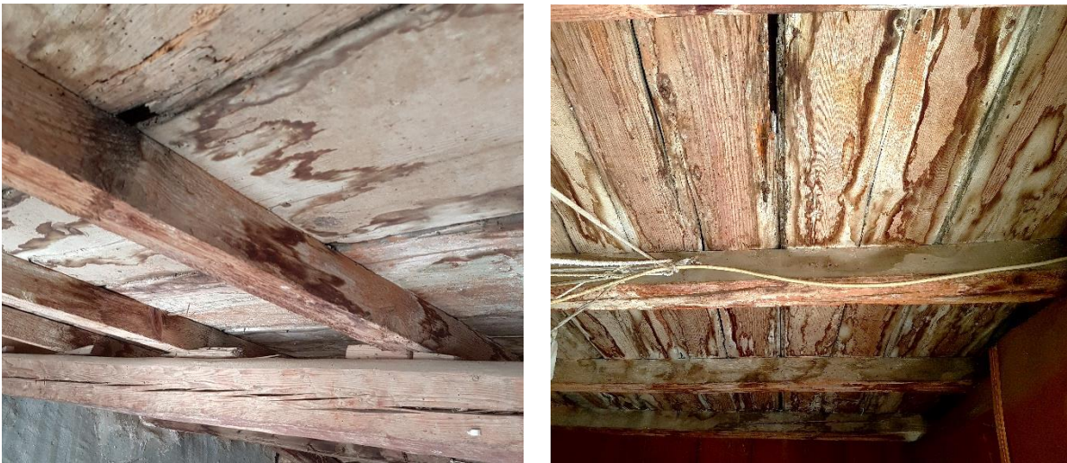
Εικόνες 3.9 – Διάβρωση της ξυλείας που αποτελεί τον φέροντα οργανισμό της στέγης
