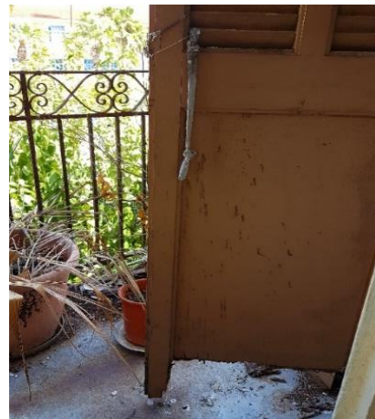
Εικόνες 3.7 – Φθορές σε εξωτερικά παντζούρια και σπασμένες γρίλιες
