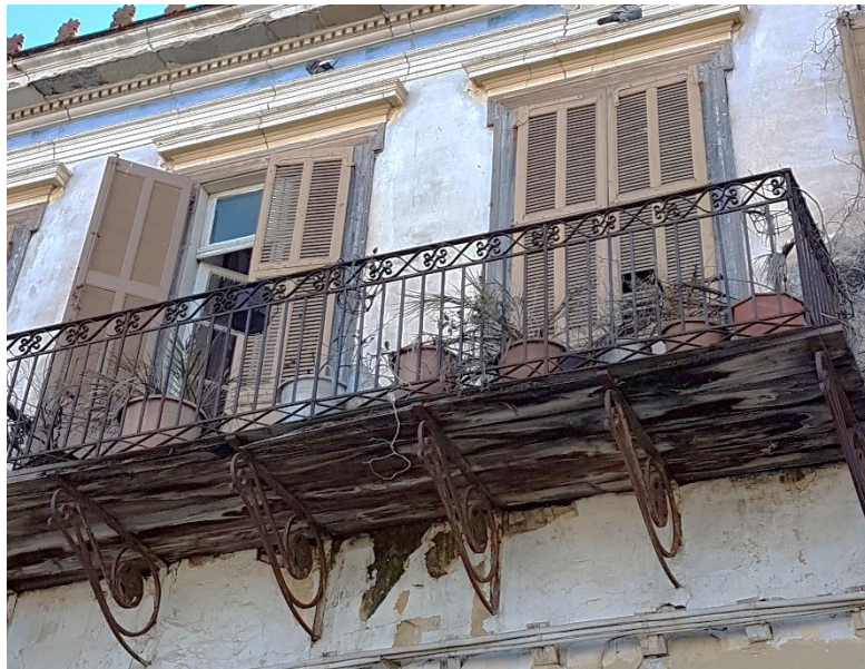
Εικόνα 3.5 – Φθορές σε εξωτερικά παντζούρια και σπασμένες γρίλιες
