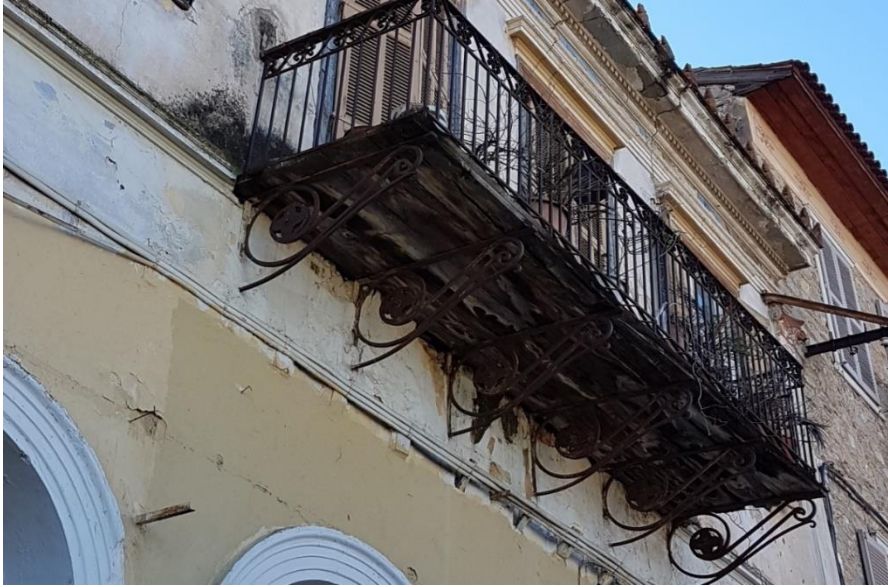
Εικόνα 2.36 - Μπαλκόνι της Βόρειας όψης
