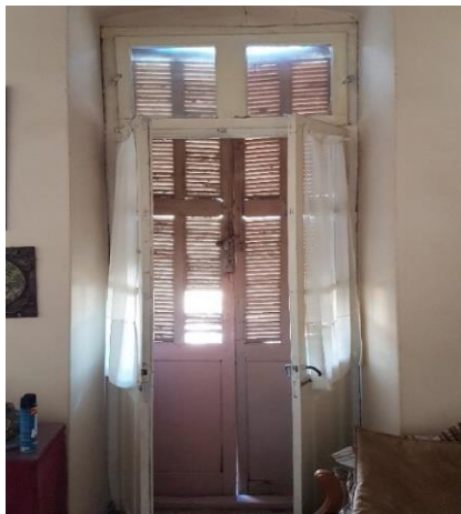
Εικόνες 3.7 – Φθορές σε εξωτερικά παντζούρια και σπασμένες γρίλιες
