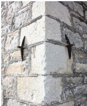
Εικόνα 5.3 – Μεταλλικοί ελκυστήρες στη γωνία κτιρίου (Φωτογραφία από την ηλεκτρονική σελίδα του Ε.Μ.Π. Σχολή Αρχιτεκτόνων-Μηχανικών, «Αρχιτεκτονική Ανάλυση Παραδοσιακών Κτηρίων και Συνόλων»)
