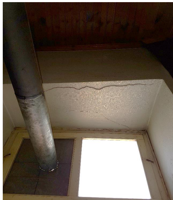
Εικόνες 3.1 – Ρηγματώσεις στις ποδιές και τα πρέκια των ανοιγμάτων
