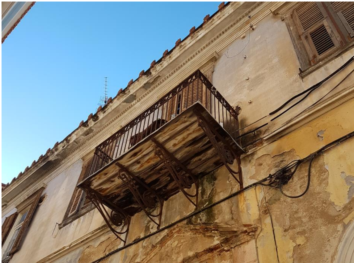
Εικόνα 2.41 - Εξώστης ανατολικής όψης α' ορόφου
