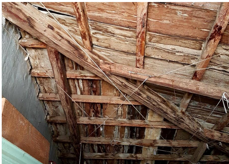
Εικόνα 2.27 Σοφίτα και στέγη
