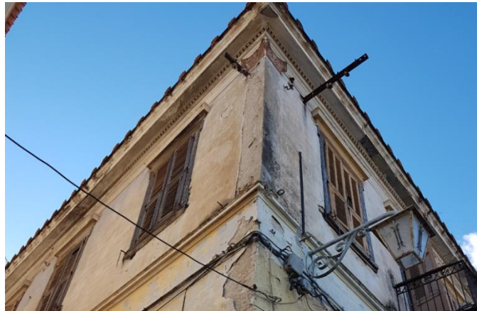
Εικόνα 2.22 - Γωνιακή παραστάδα με κεραμικό επίκρανο
