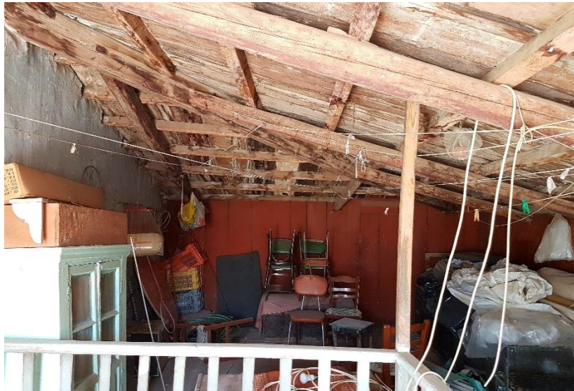
Εικόνα 2.26 - Σοφίτα και στέγη
