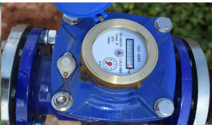
Εικόνα 12: Παροχόμετρο (Υδρόμετρο).
