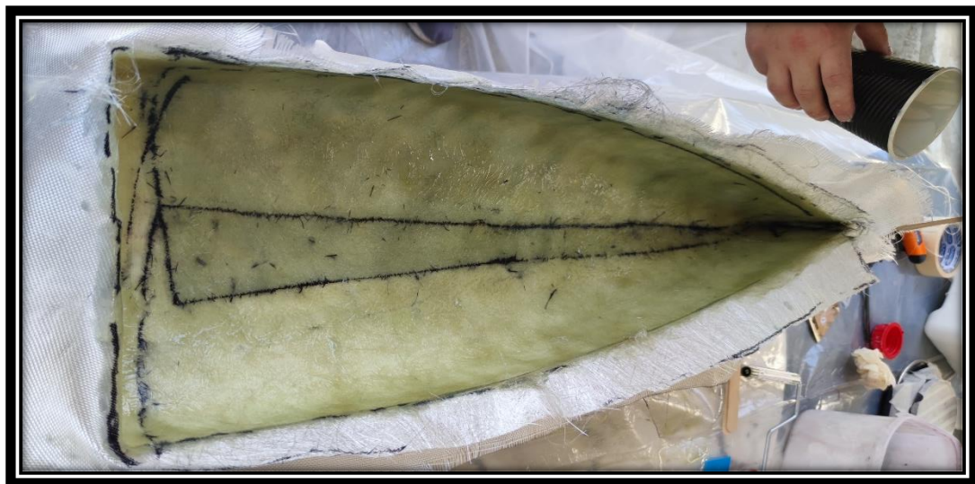
Εικόνα 3.3-14: Τοποθέτηση και εμποτισμός των τομέων 1 και 2 του υαλοπλήματος MAT450.
