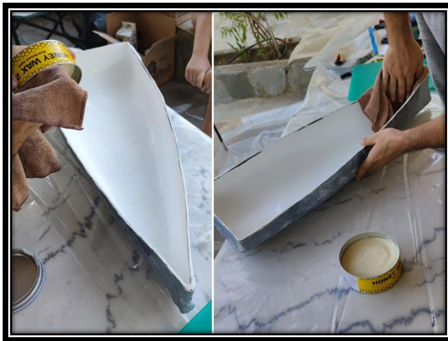
Εικόνα 3.3-10: Προετοιμασία επιφάνειας με αποκολλητικό κεριό.
