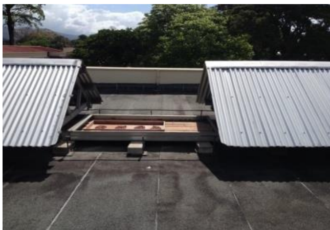
Εικόνα 24: Ξήρανση κόκκων κακάο με έκθεση στον ήλιο χρήσει κινητών οροφών (Πηγή: https://www.researchgate.net/figure/Miniature-Cocoa-House-used-for-drying-beans-a-Opened-roof-exposing-the-cocoa-beans-to_fig1_327078894 )
