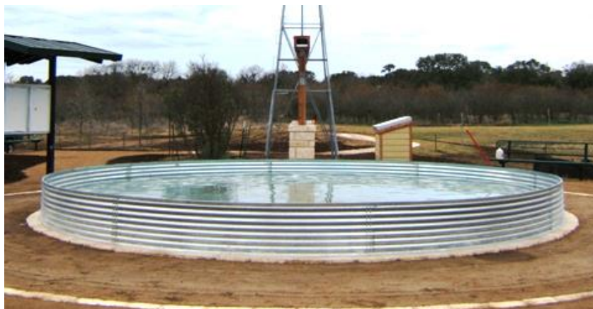
Σχήμα 2-14 Δεξαμενή Ανοιχτής Οροφής (Water Storage Tanks).
