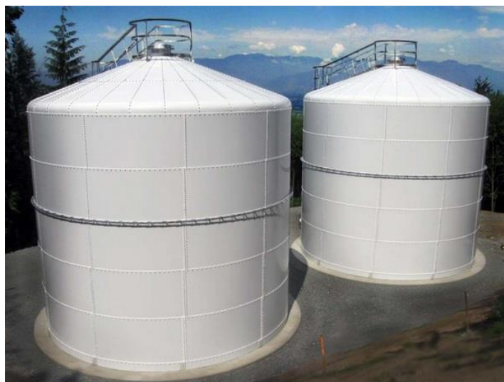
Σχήμα 2-12 Δεξαμενές Σταθερής Οροφής (Engineering).
