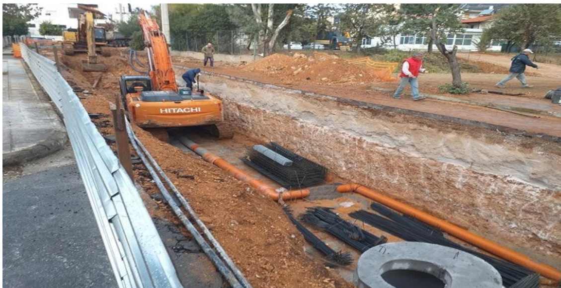
Εικόνα 23: αντιπλημμυρικά έργα κατά την κατασκευή τους στο Δήμο Φυλής [28]
